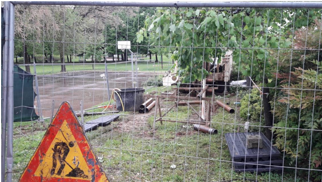
SONDAGGIO MW19: postazione
