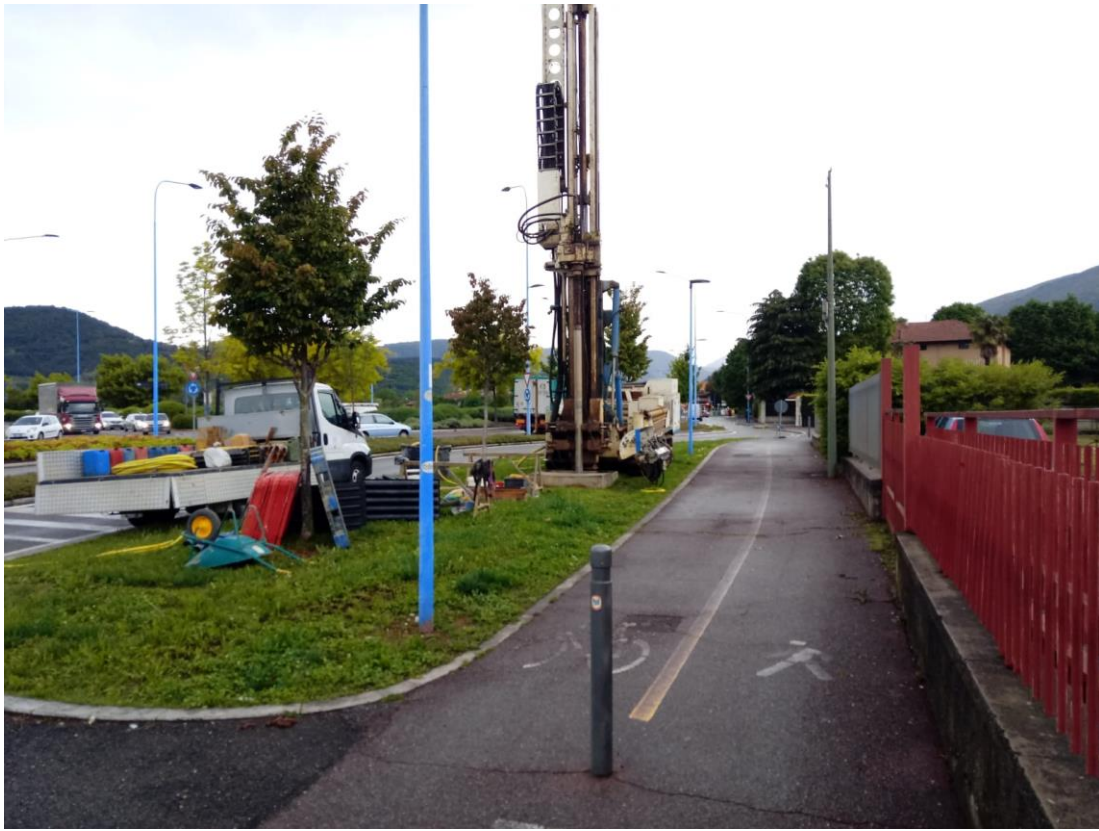
SONDAGGIO MW13: postazione
