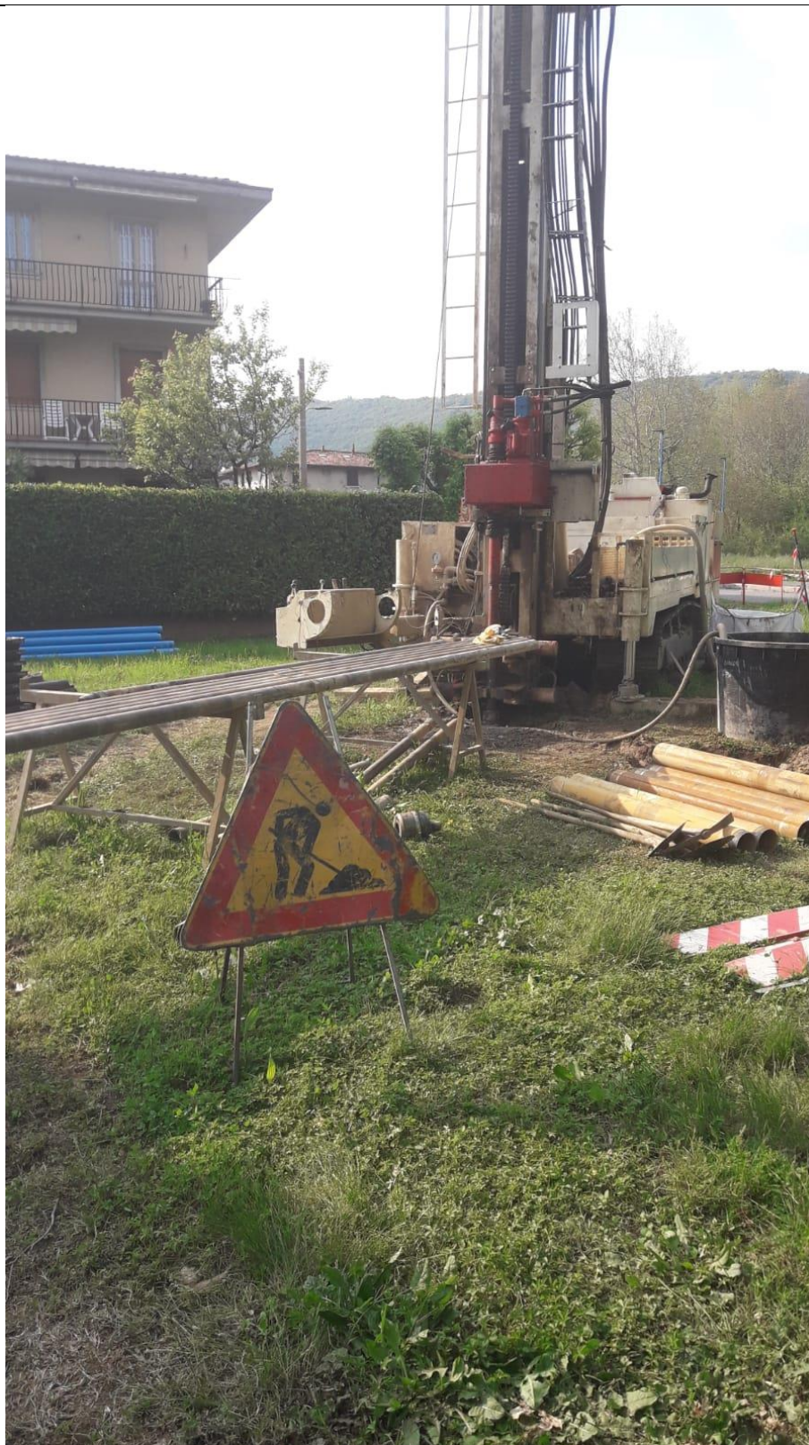
SONDAGGIO MW17: postazione
