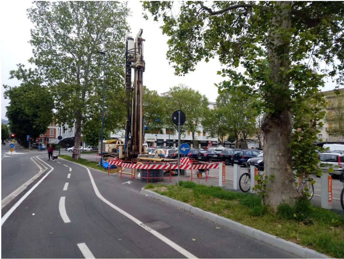
SONDAGGIO MW2: postazione
