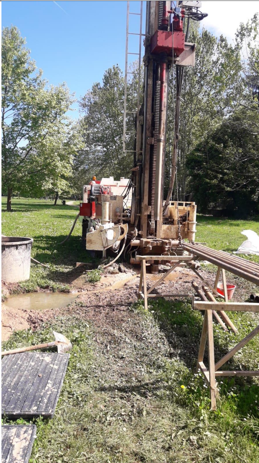
SONDAGGIO MW16: postazione
