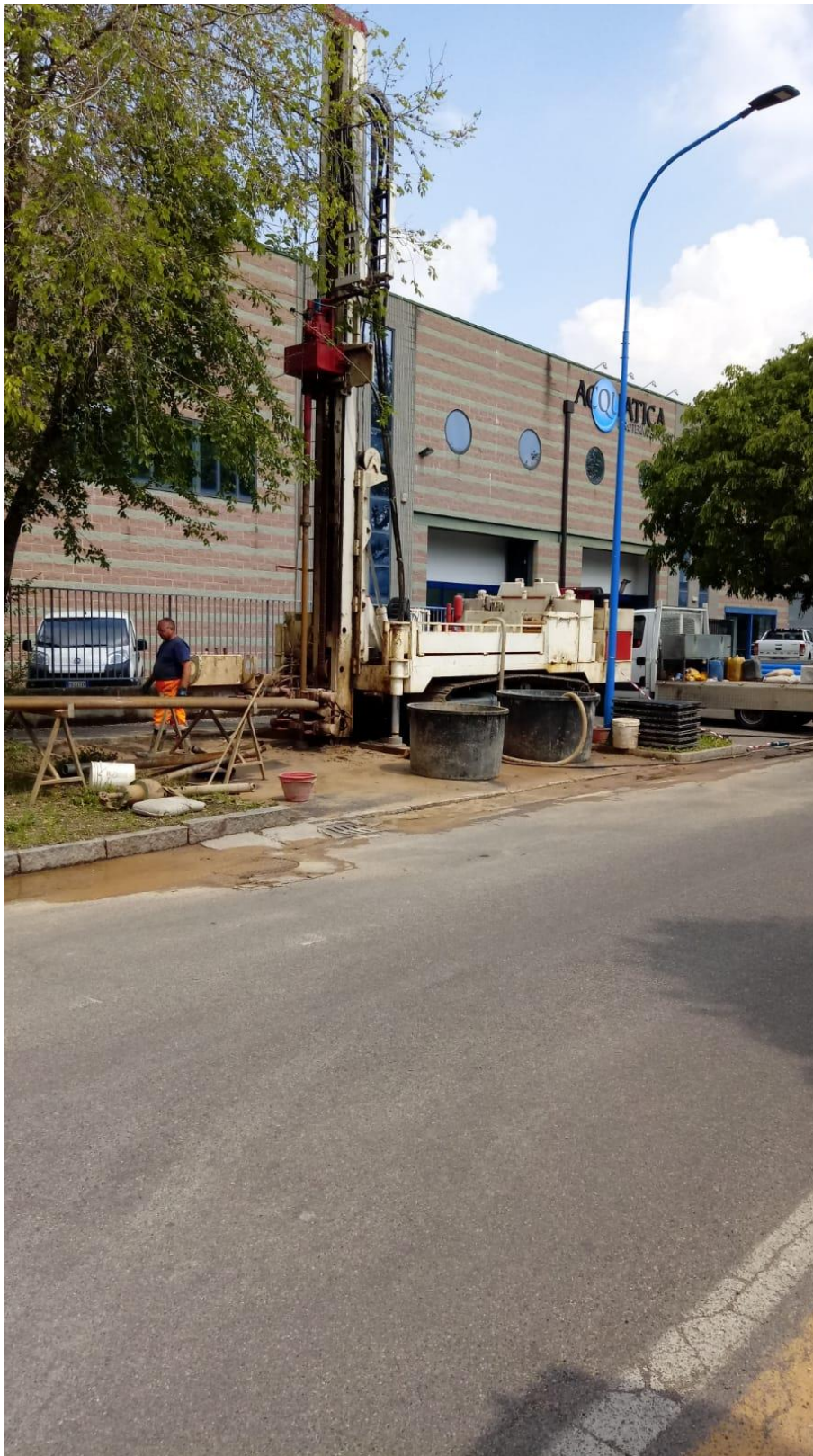
SONDAGGIO MW20: postazione
