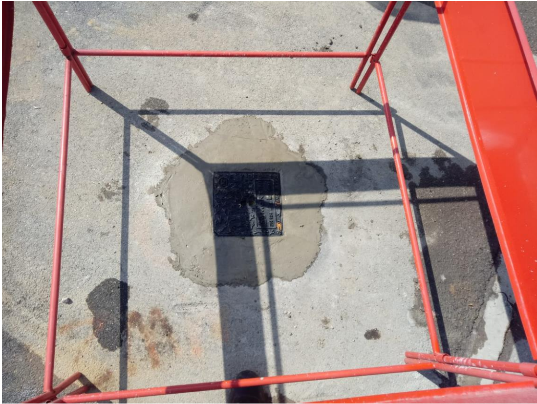
SONDAGGIO MW2: Ripristino con pozzetto carrabile
