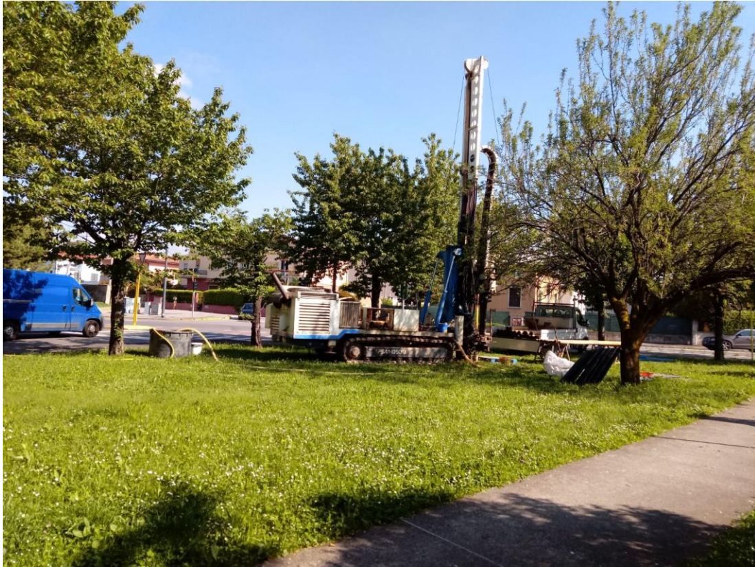
SONDAGGIO MW1: postazione
