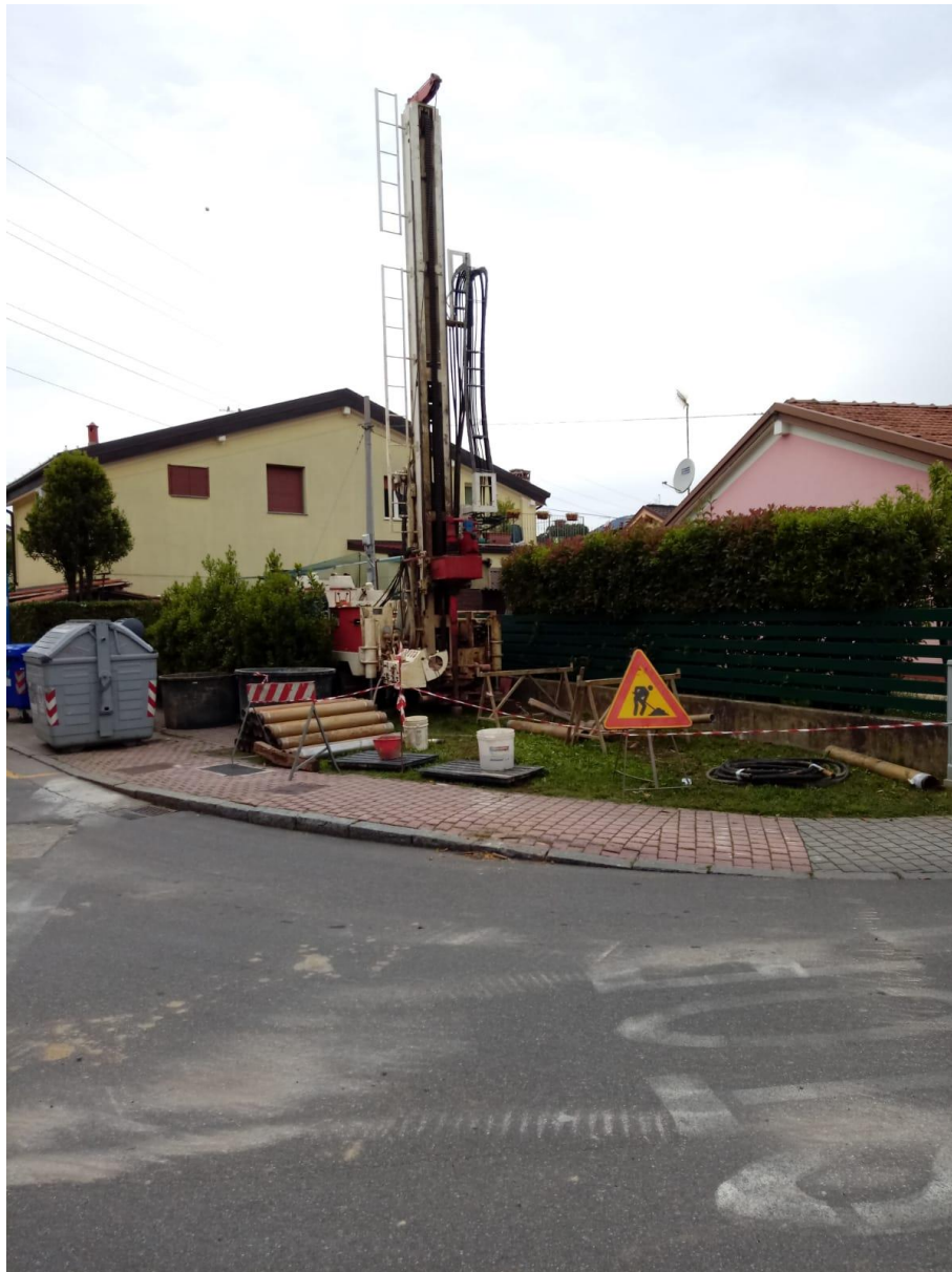
SONDAGGIO MW12: postazione
