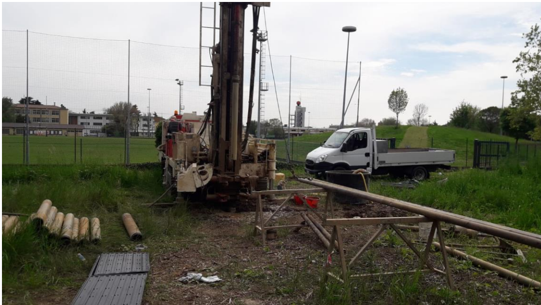
SONDAGGIO MW18: postazione
