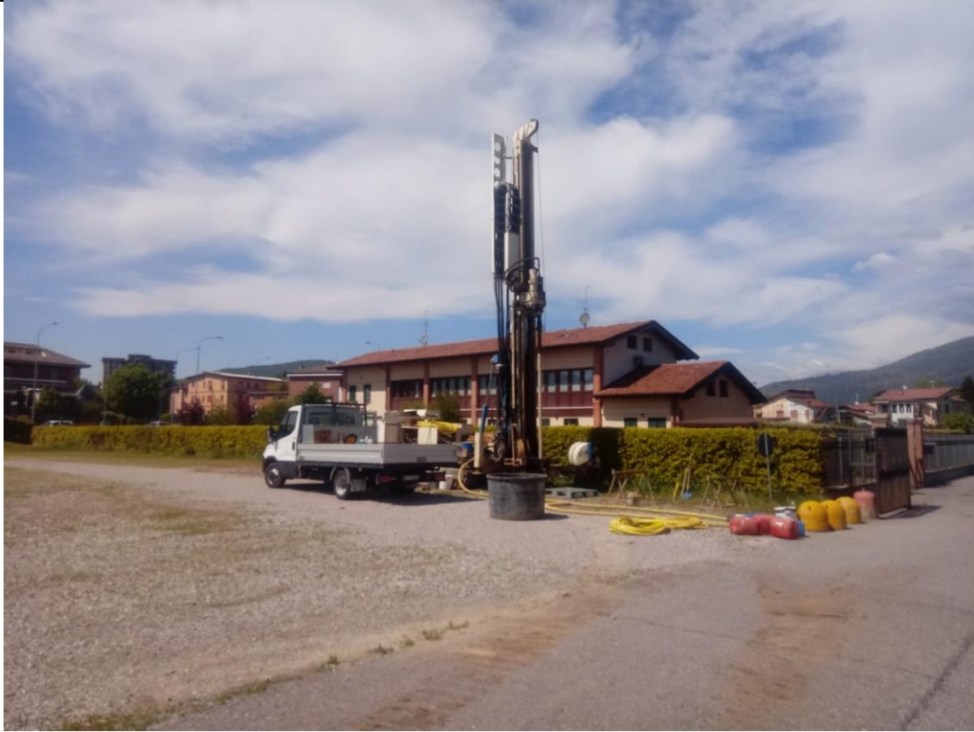
SONDAGGIO MW14: postazione
