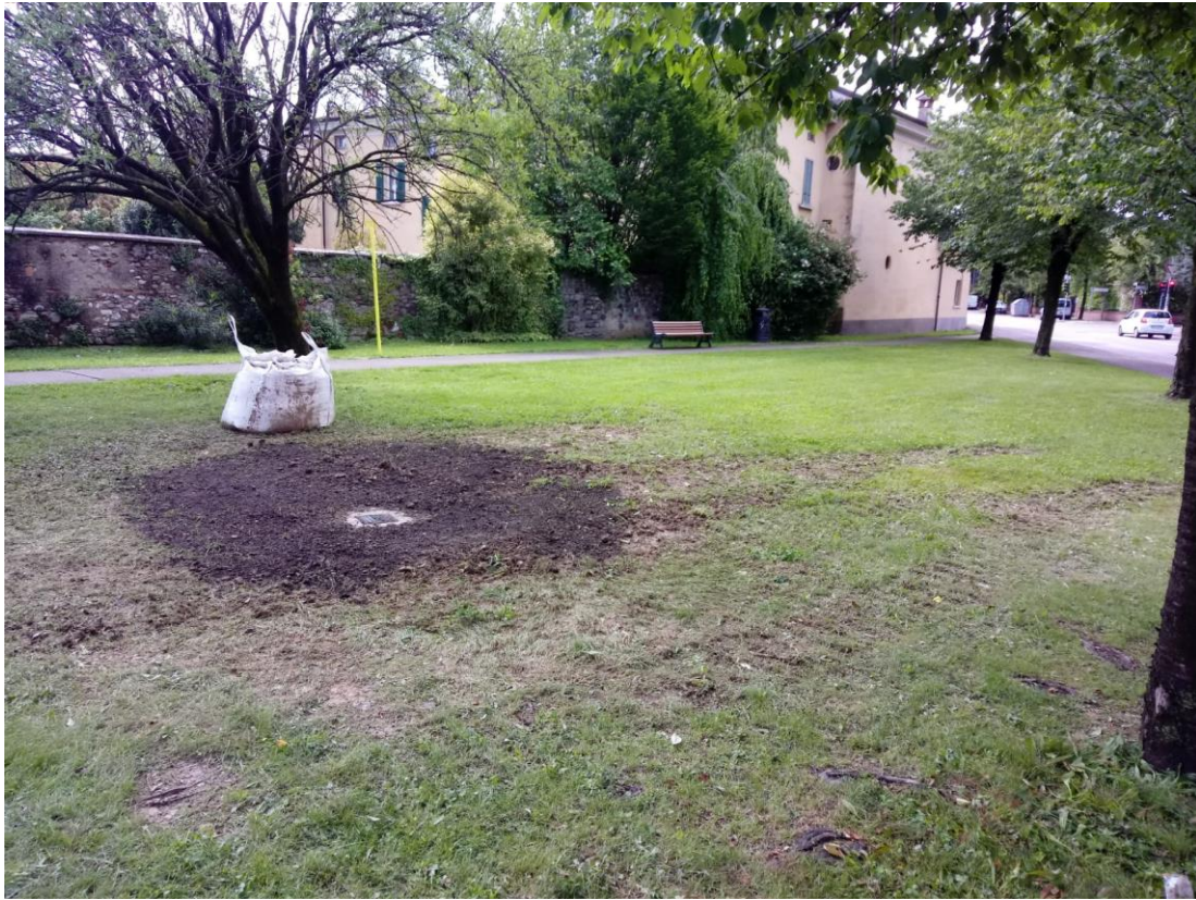
SONDAGGIO MW1: Ripristino tramite pozzetto carrabile
