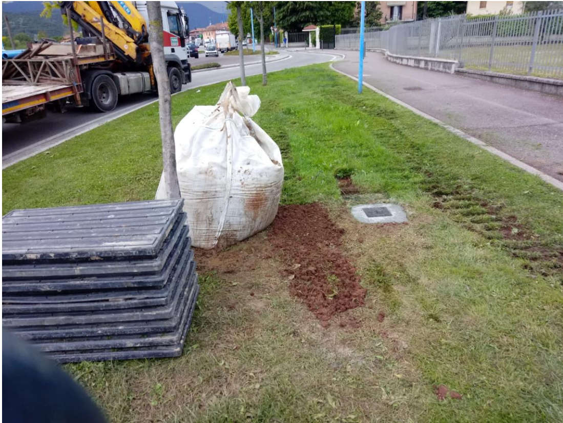
SONDAGGIO MW13: Ripristino con chiusino carrabile
