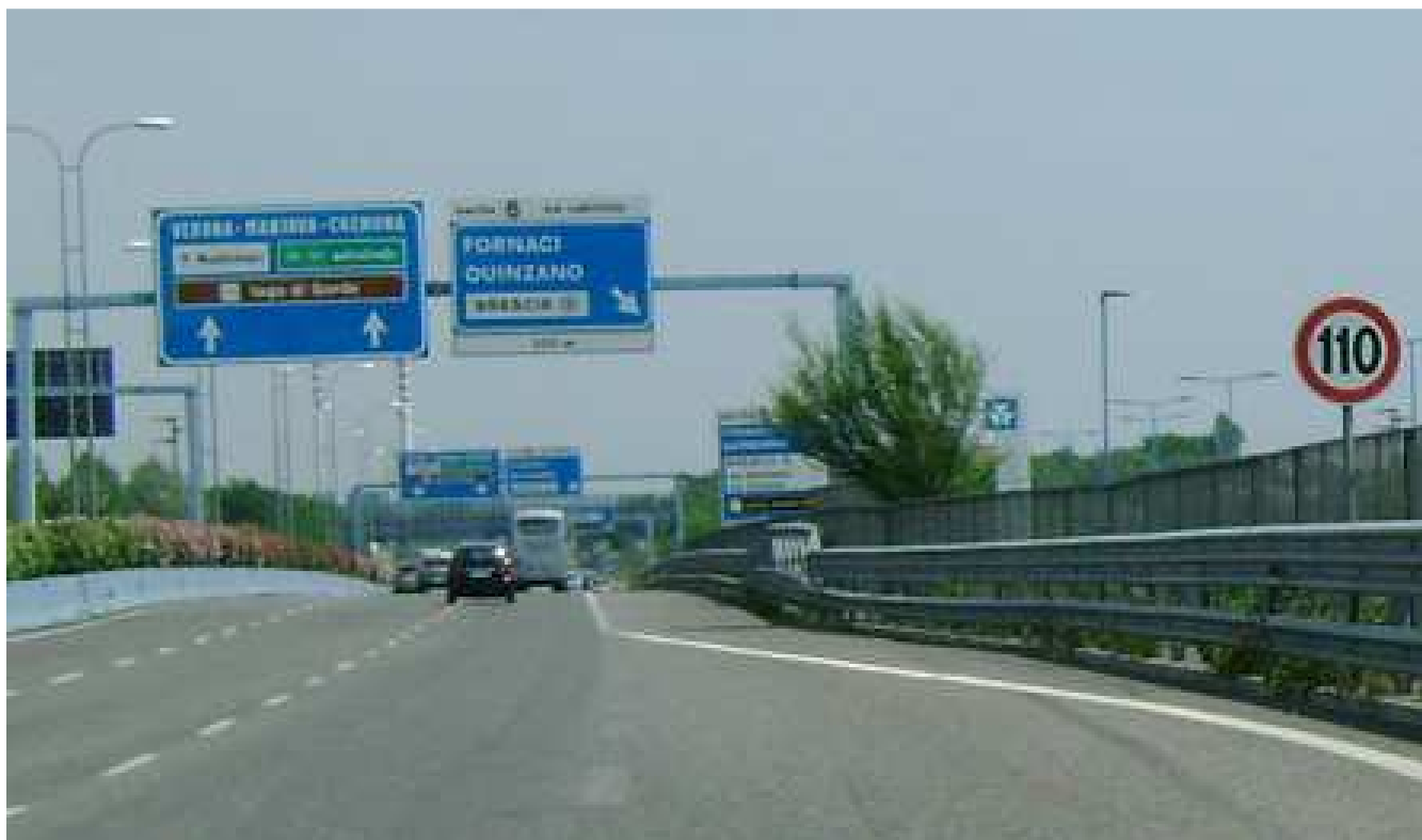
Km 5+400 - Segnale limite 110 km/h
