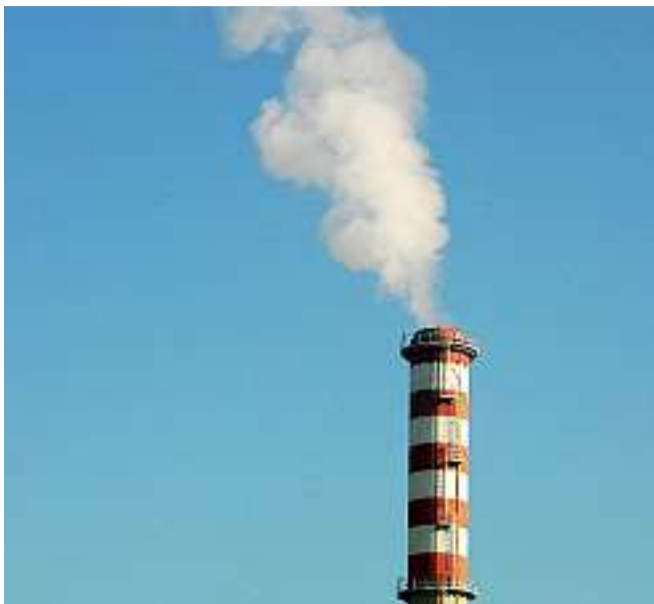
La ciminiera della centrale Nord del teleriscaldamento
