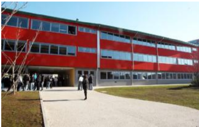
Al Don Milani di Montichiari si studia una mini centrale idroelettrica
