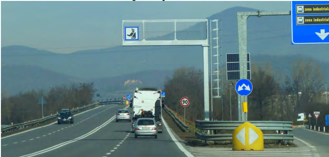
Postazione di controllo - telecamera - km 1+674
