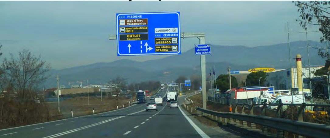
Secondo segnale di preavviso - km 1+305
