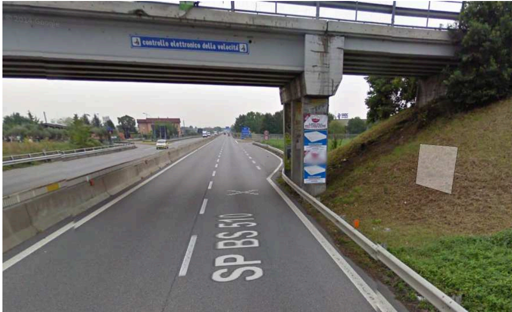
Figura 1 - Km 7+527 - Primo segnale di preavviso
