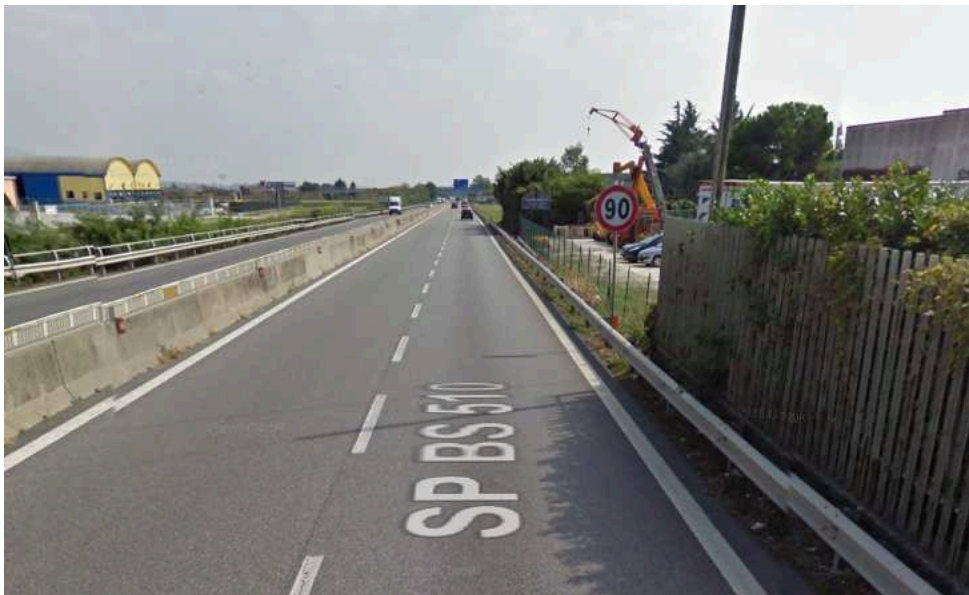
Figura 2 - Km 7+250 - segnale di prescrizione limite di velocità, posizionato dopo l'immissione da Passirano
