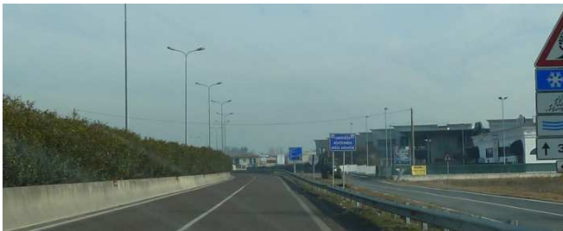
Figura 2 - km 7+485 - primo segnale di preavviso
