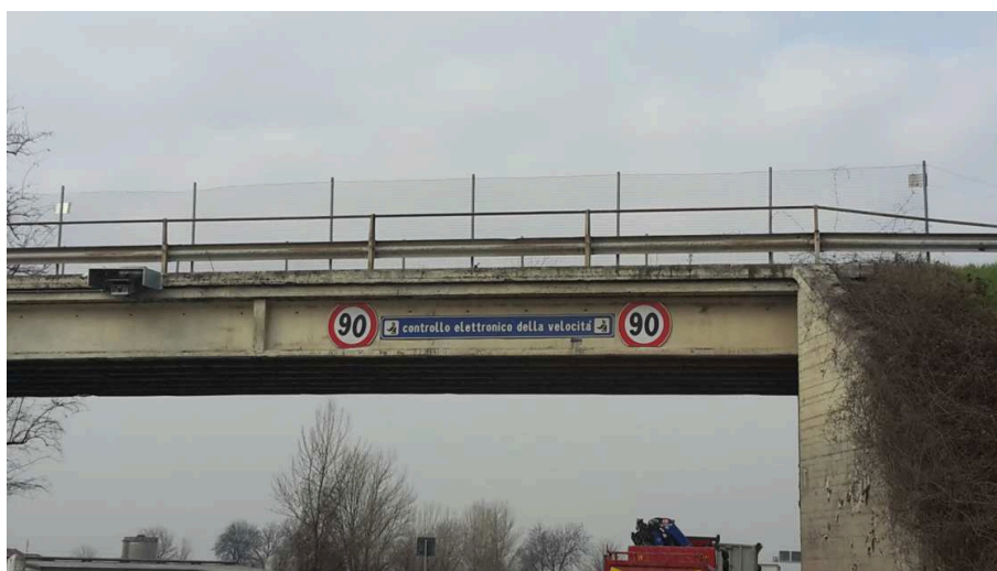
Figura 2: Primo segnale di preavviso, km 15+505
