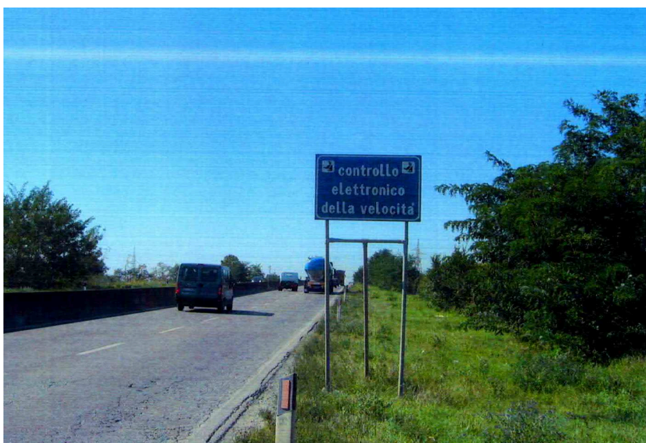
Figura 3: Secondo segnale di preavviso, km 15+199
