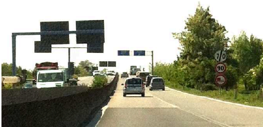
Figura 1: Segnale di prescrizione limite di velocità al Km 16+500
