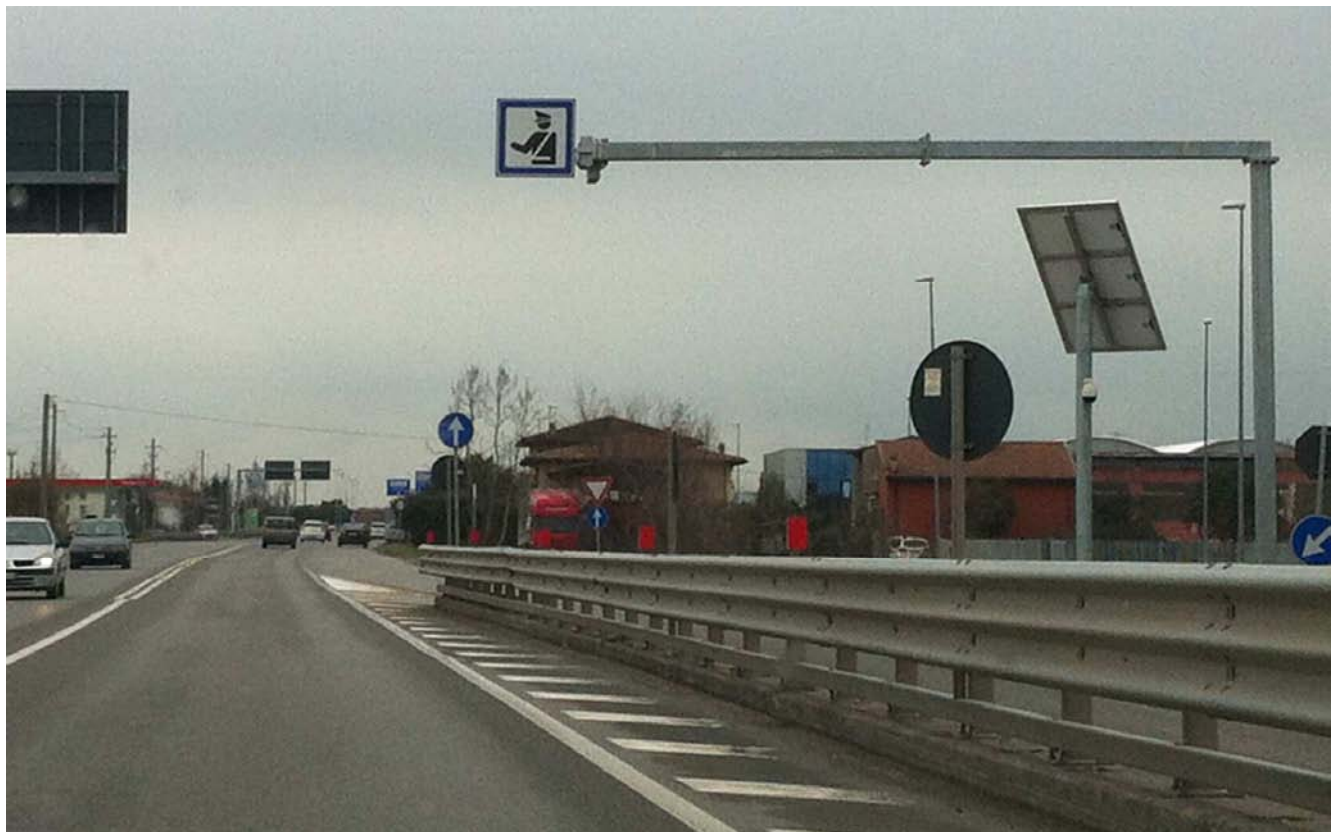
Postazione di controllo - telecamera - km 46+838
