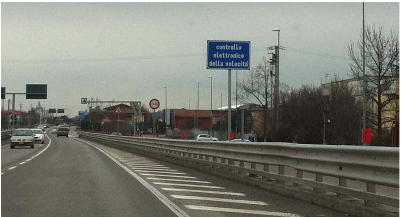
Secondo segnale di preavviso - km 46+978
