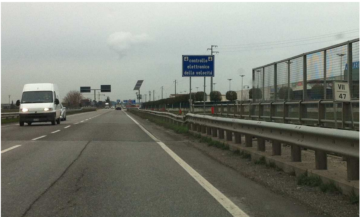
Secondo segnale di preavviso - km 47+725
