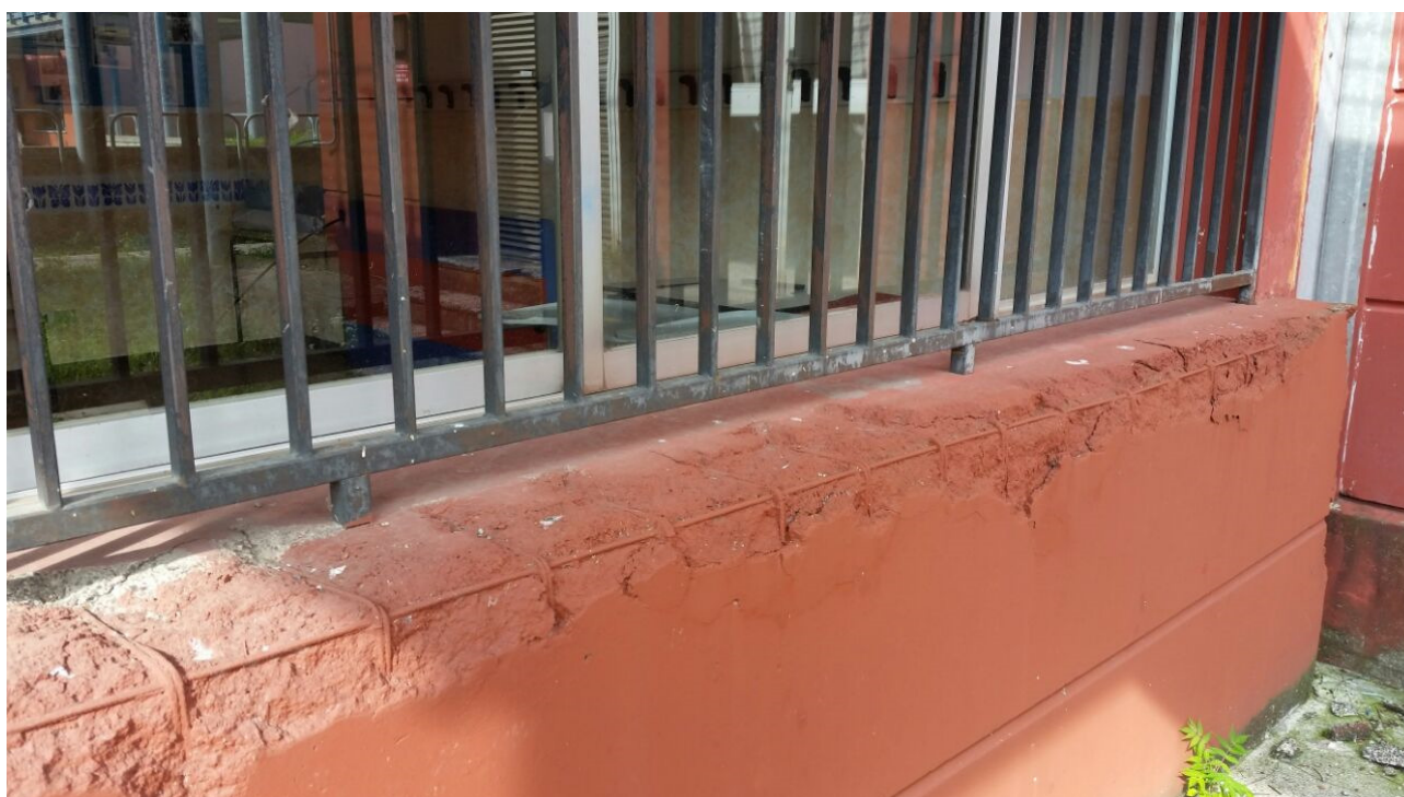
Immagine 7: Copriferro deteriorato
