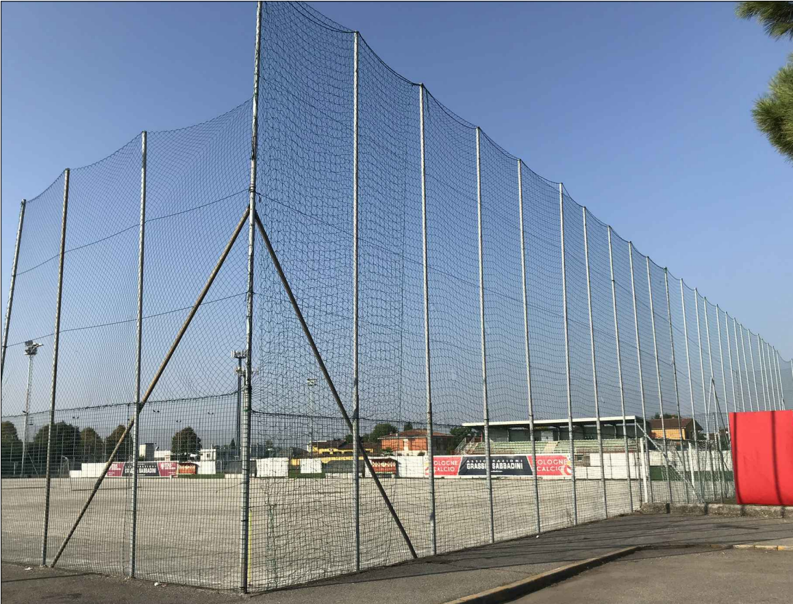
Rimozione di recinzione parapalloni H=8,00m
