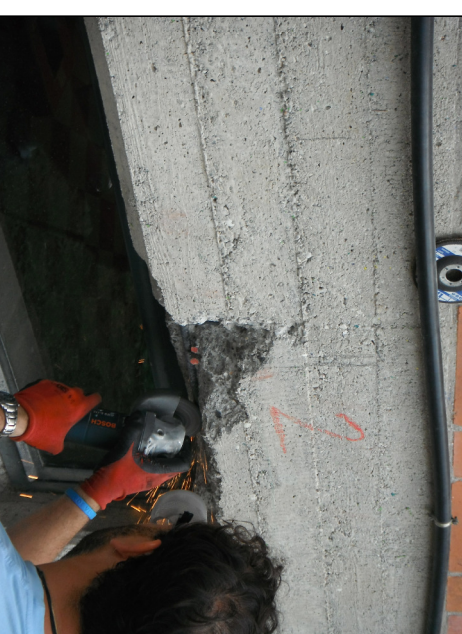
2 Valutazione resistenza meccanica dell'acciaio con microduremetro e misurazione diretta di \sigma e copriferro
