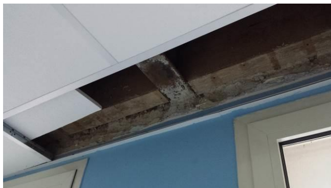
A sinistra Impalcato in acciaio e Legno del piano terra. A destra documentazione fotografica delle impronte su profilo in acciaio delle prove di durezza Brinnell per la caratterizzazione dell'acciaio da carpenteria.
