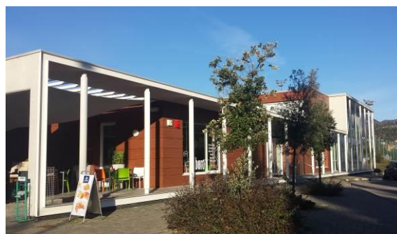
Piscina comunale di Salò. Ampliamento al termine dei lavori.
