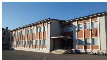
Scuola Elementare Turla – Corpo A
