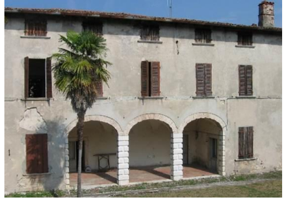
Corpo principale dell'edificio in via Marconi.
