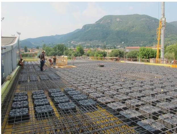
Piastra alleggerita con casseri a perdere in PVC del primo impalcato fuori terra
