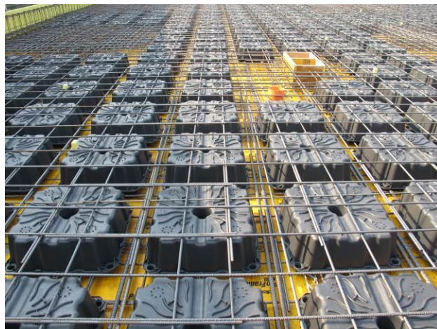
Piastra alleggerita con casseri a perdere in PVC del primo impalcato fuori terra. Dettaglio
