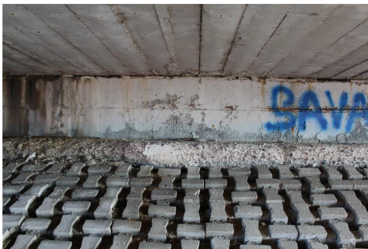
Figura 104: Manufatto BSSPEXSS45B_P001: spalla M2 (centro).
