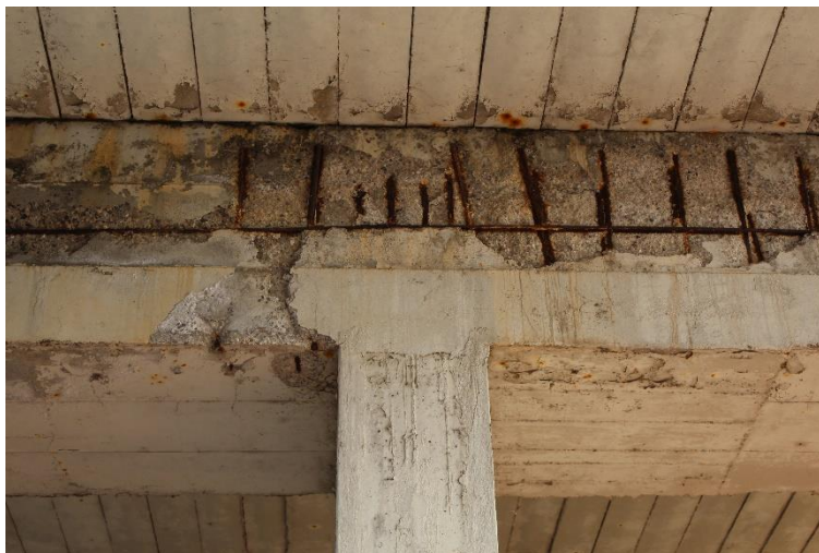
Figura 80: Manufatto BSSPEXSS45B_P001: pilastro P7 (apice).
