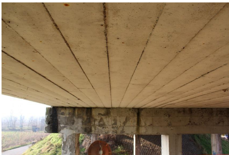
Figura 106: Manufatto BSSPEXSS45B_P001: travetti t301...t352 (lato est).
