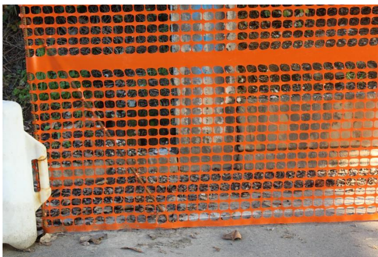
Figura 85: Manufatto BSSPEXSS45B_P001: pilastro P8 (base).
