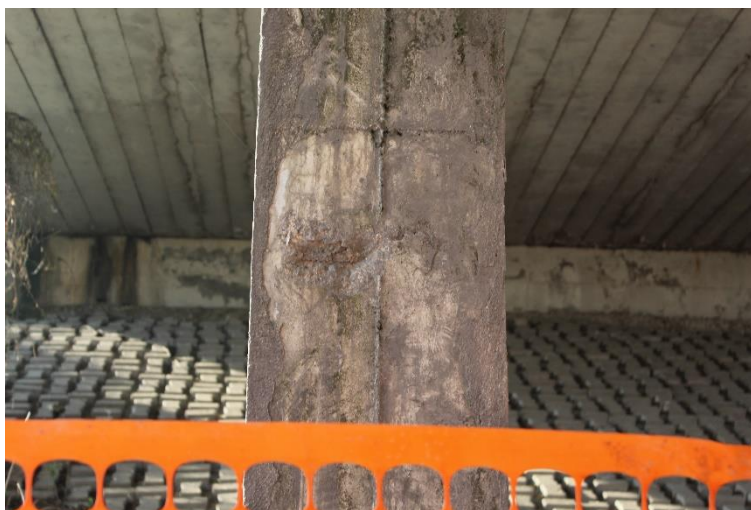
Figura 66: Manufatto BSSPEXSS45B_P001: pilastro P2 (fusto).
