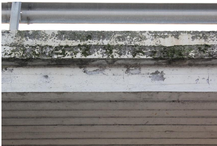
Figura 53: Manufatto BSSPEXSS45B_P004: cordolo C1 (campata centrale).
