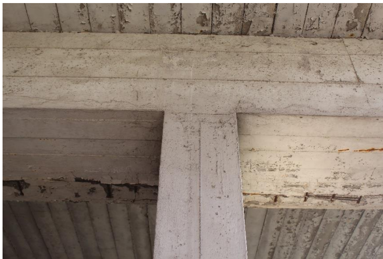
Figura 11: Manufatto BSSPEXSS45B_P004: pilastro P3 (apice).
