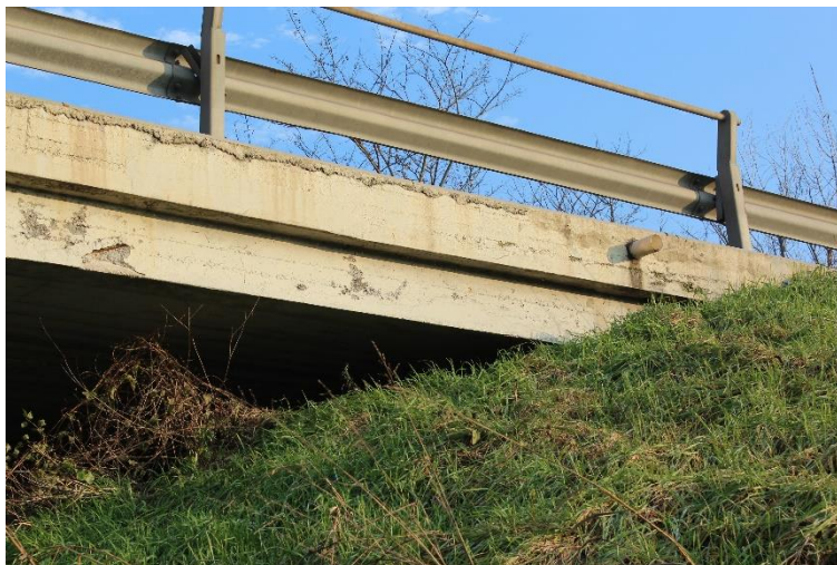
Figura 55: Manufatto BSSPEXSS45B_P004: cordolo C2 (campata sud).
