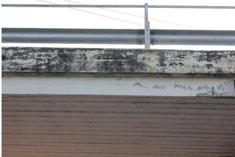
Figura 113: Manufatto BSSPEXSS45B_P001: cordolo C2 (campata centrale).
