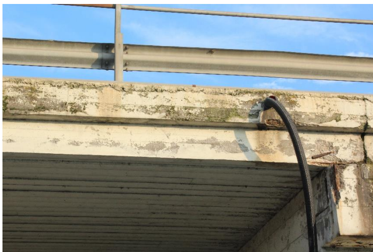
Figura 56: Manufatto BSSPEXSS45B_P004: cordolo C2 (campata centrale).
