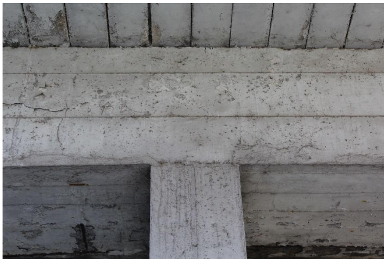
Figura 8: Manufatto BSSPEXSS45B_P004: pilastro P2 (apice).
