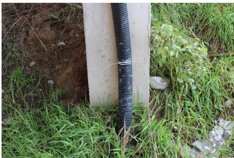
Figura 16: Manufatto BSSPEXSS45B_P004: pilastro P4 (base).
