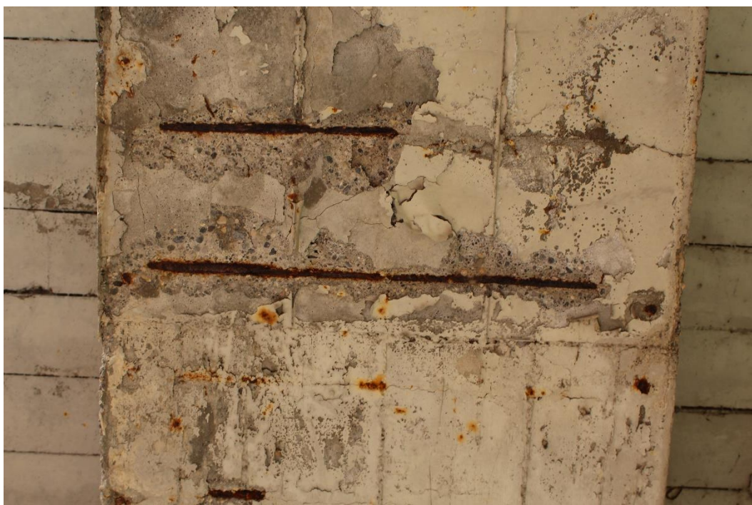
Figura 95: Manufatto BSSPEXSS45B_P001: trave T2 (campata P5-P6).
