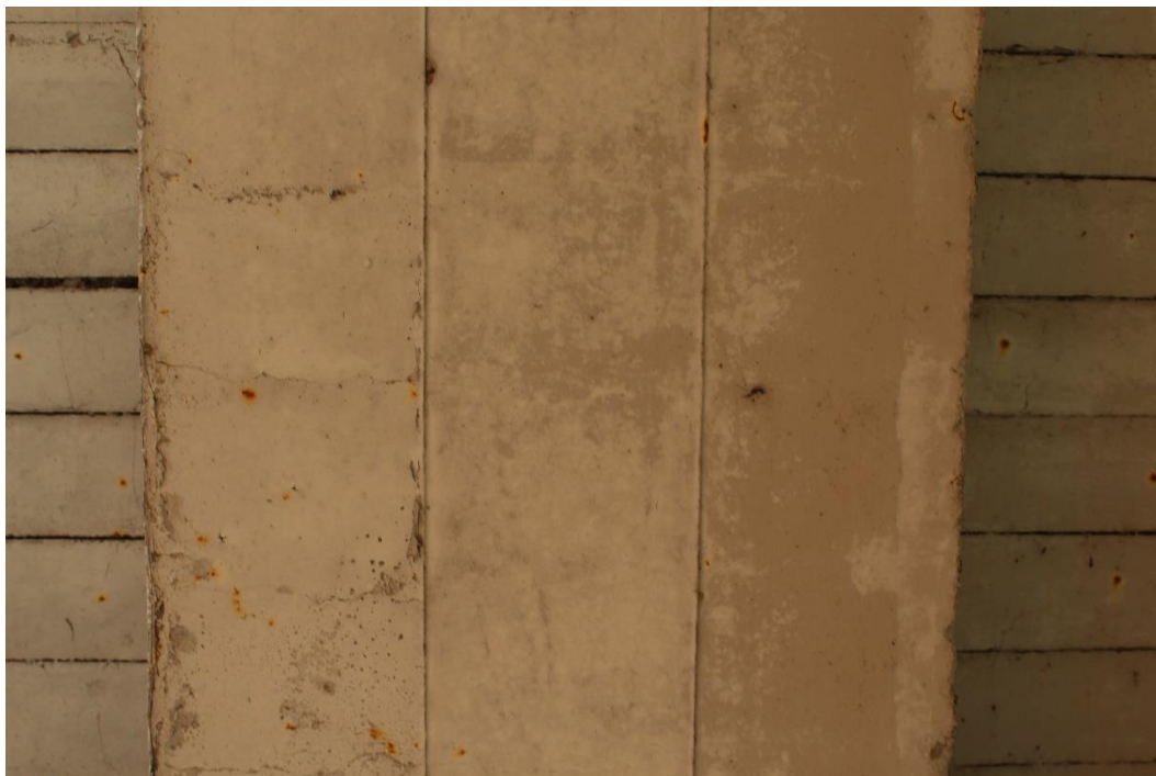
Figura 96: Manufatto BSSPEXSS45B_P001: trave T2 (campata P6-P7).
