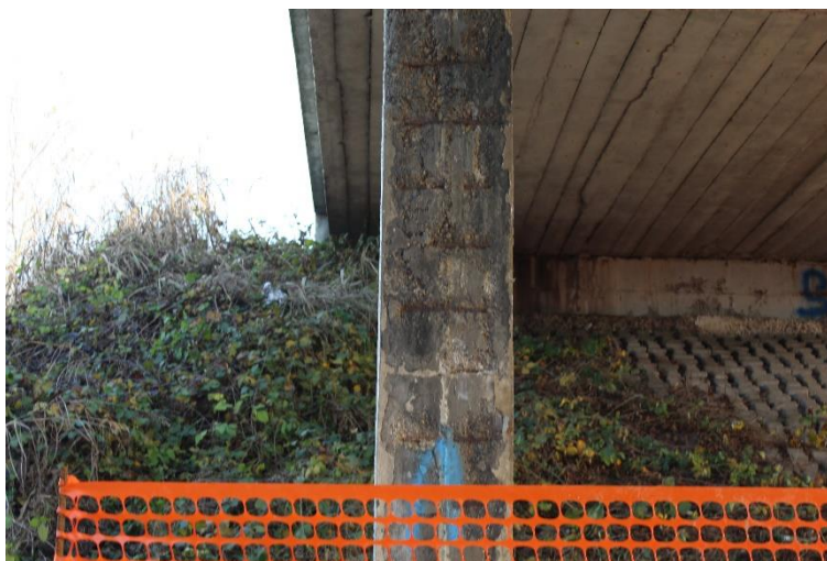
Figura 84: Manufatto BSSPEXSS45B_P001: pilastro P8 (fusto).
