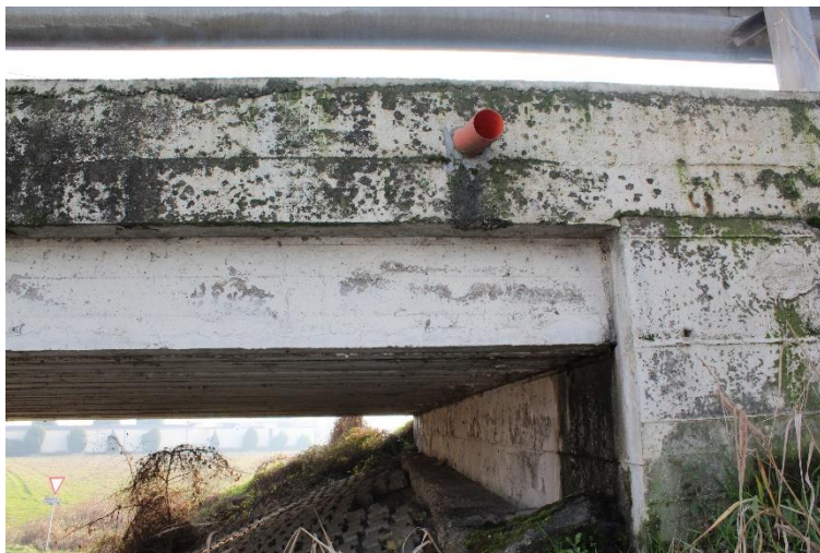
Figura 112: Manufatto BSSPEXSS45B_P001: cordolo C2 (campata sud).
