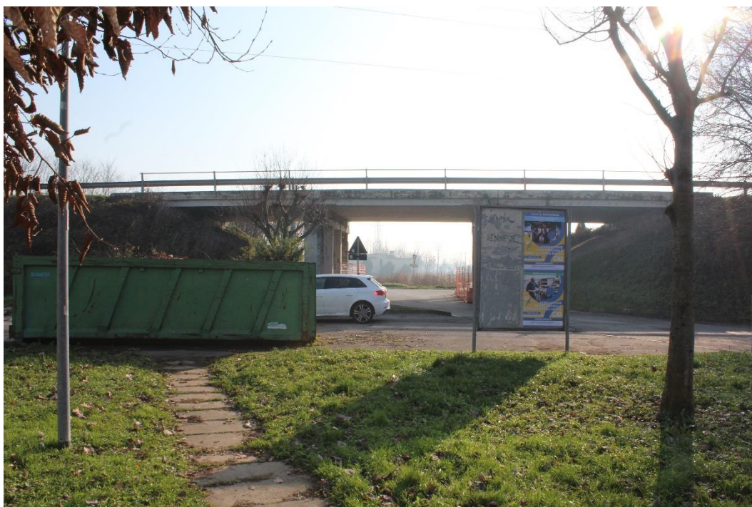
Figura 59: Manufatto BSSPEXSS45B_P001: prospetto ovest.
