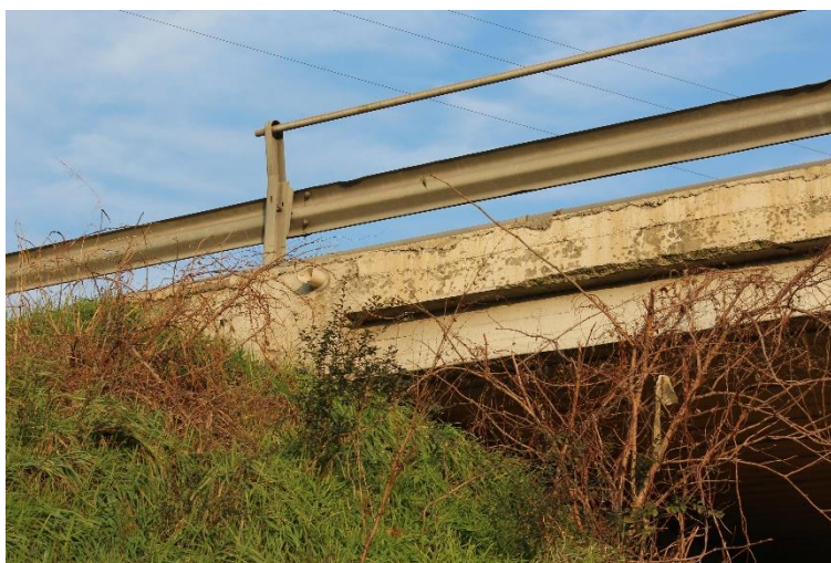
Figura 57: Manufatto BSSPEXSS45B_P004: cordolo C2 (campata nord).
