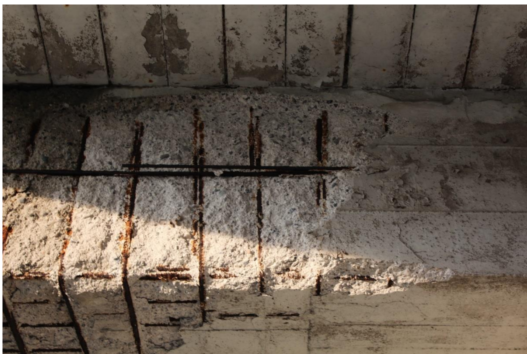
Figura 38: Manufatto BSSPEXSS45B_P004: trave T2 (campata P7-P8).
