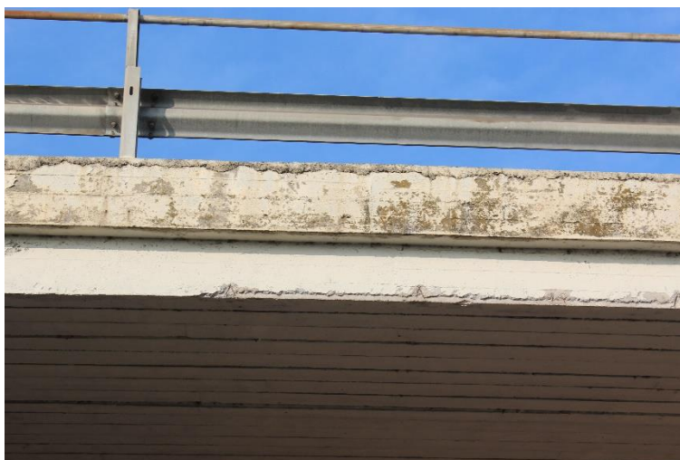
Figura 110: Manufatto BSSPEXSS45B_P001: cordolo C1 (campata centrale).
