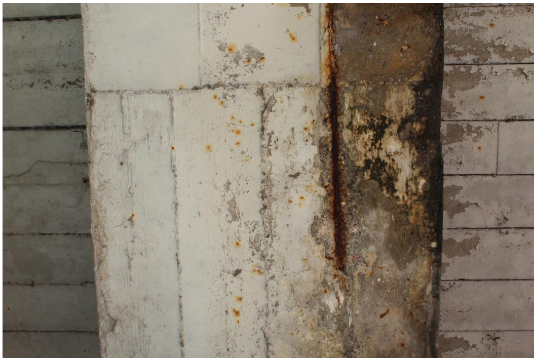
Figura 88: Manufatto BSSPEXSS45B_P001: trave T1 (campata P3-P4).
