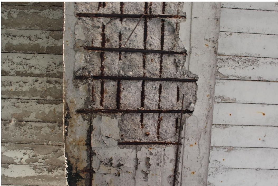
Figura 33: Manufatto BSSPEXSS45B_P004: trave T1 (campata P2-P1).
