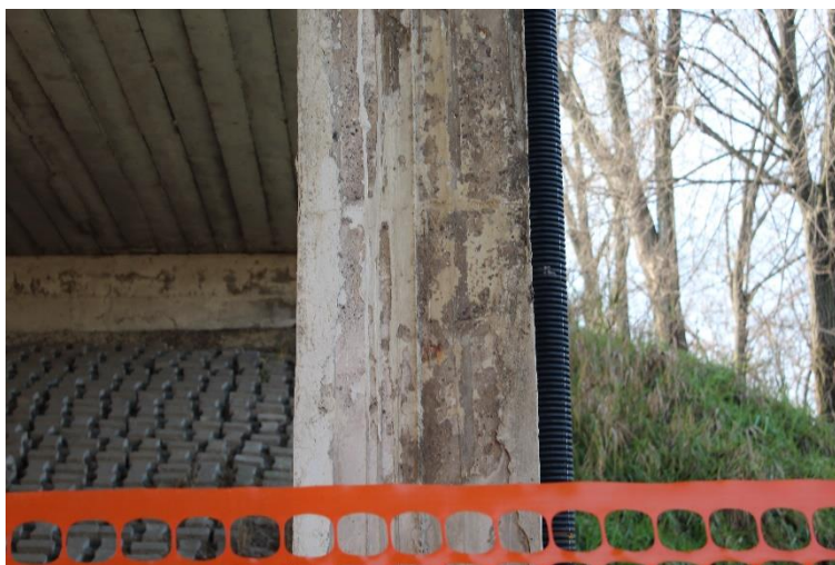
Figura 72: Manufatto BSSPEXSS45B_P001: pilastro P4 (fusto).
