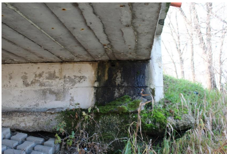
Figura 102: Manufatto BSSPEXSS45B_P001: spalla M1 (lato ovest).
