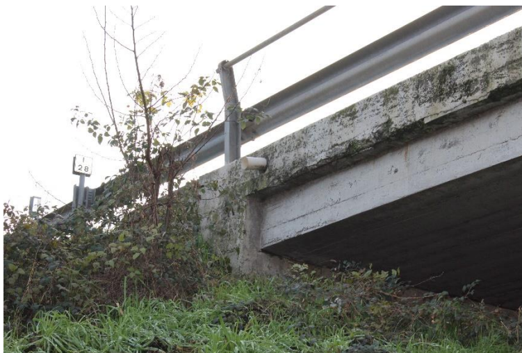
Figura 52: Manufatto BSSPEXSS45B_P004: cordolo C1 (campata sud).
