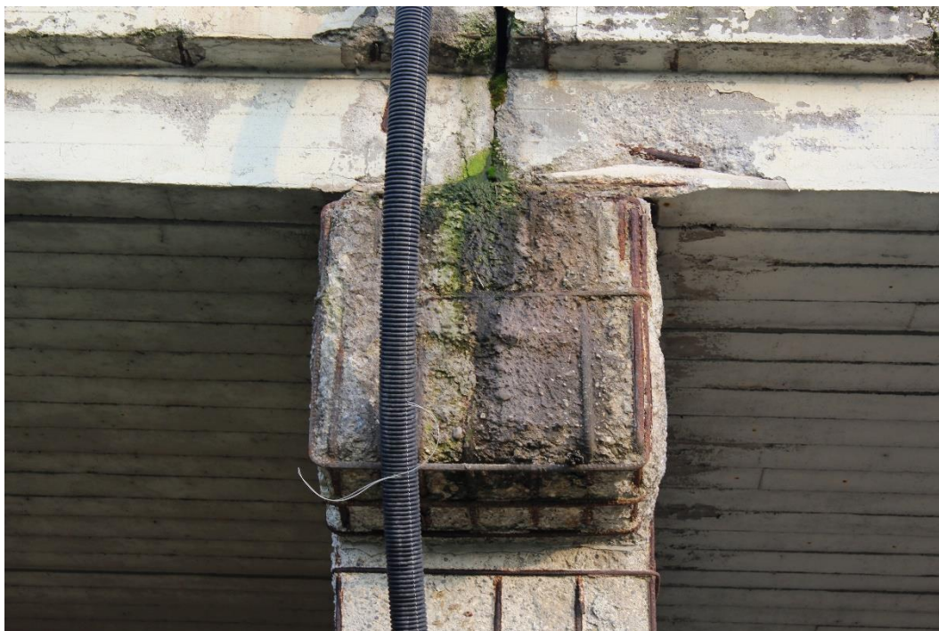
Figura 36: Manufatto BSSPEXSS45B_P004: trave T2 (mensola).
