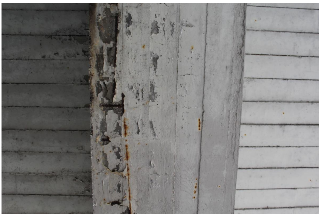
Figura 32: Manufatto BSSPEXSS45B_P004: trave T1 (campata P2-P3).
