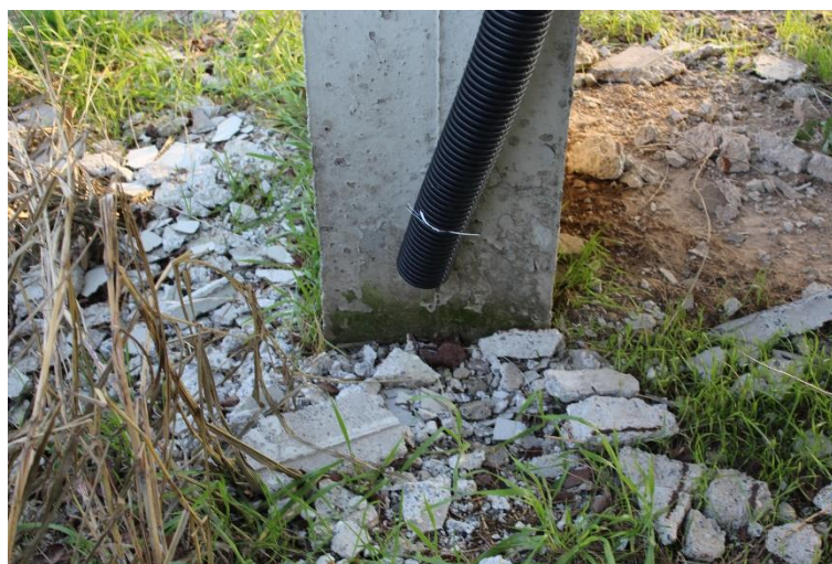
Figura 19: Manufatto BSSPEXSS45B_P004: pilastro P5 (base).
