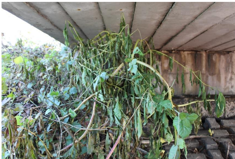
Figura 103: Manufatto BSSPEXSS45B_P001: spalla M2 (lato ovest).
