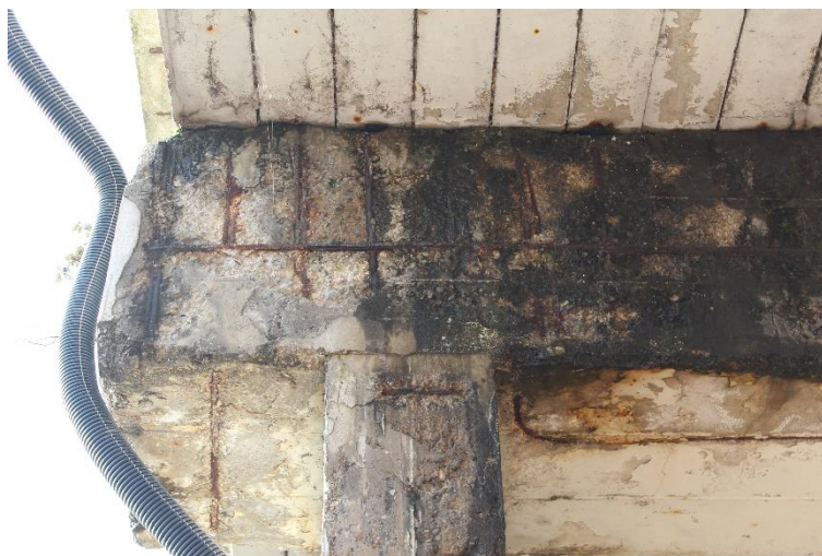
Figura 62: Manufatto BSSPEXSS45B_P001: pilastro P1 (apice).
