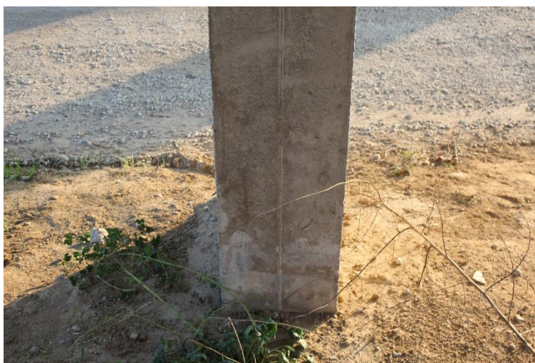
Figura 22: Manufatto BSSPEXSS45B_P004: pilastro P6 (base).
