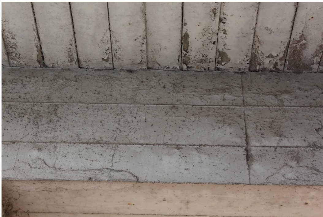
Figura 39: Manufatto BSSPEXSS45B_P004: trave T2 (campata P6-P7).
