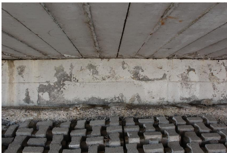
Figura 101: Manufatto BSSPEXSS45B_P001: spalla M1 (centro).
