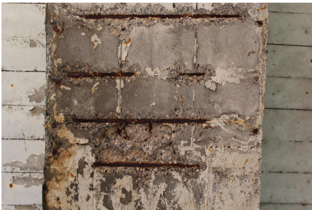
Figura 97: Manufatto BSSPEXSS45B_P001: trave T2 (campata P7-P8).
