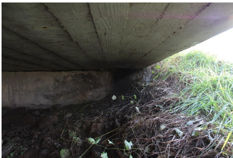
Figura 45: Manufatto BSSPEXSS45B_P004: spalla M1 (lato ovest).
