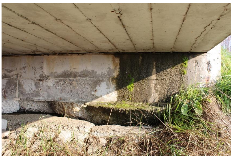
Figura 105: Manufatto BSSPEXSS45B_P001: spalla M1 (lato est).
