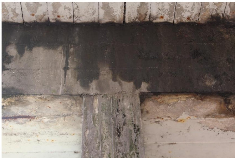
Figura 65: Manufatto BSSPEXSS45B_P001: pilastro P2 (apice).
