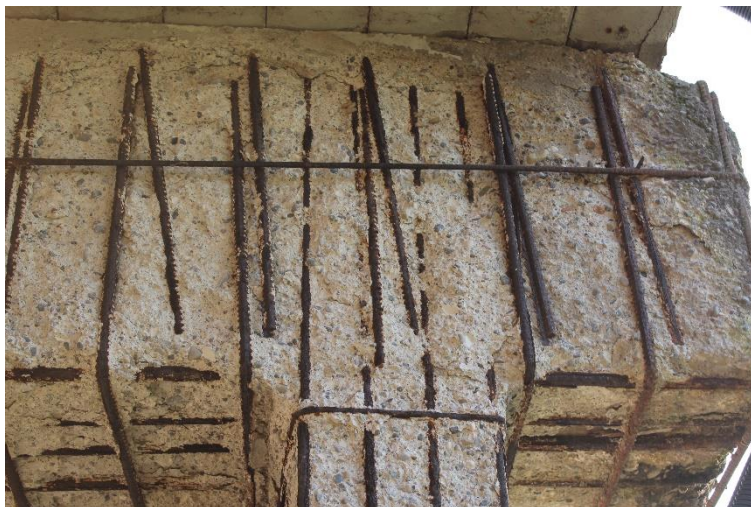
Figura 26: Manufatto BSSPEXSS45B_P004: pilastro P8 (apice).
