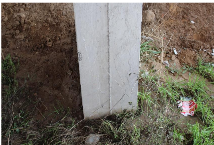
Figura 13: Manufatto BSSPEXSS45B_P004: pilastro P3 (base).
