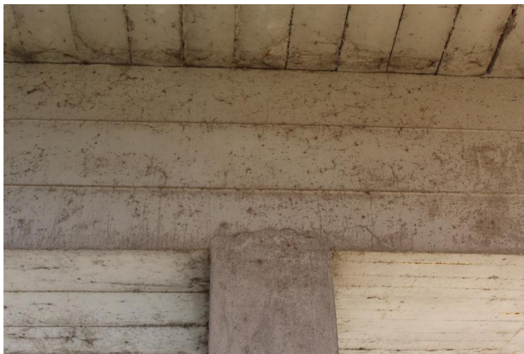
Figura 20: Manufatto BSSPEXSS45B_P004: pilastro P6 (apice).
