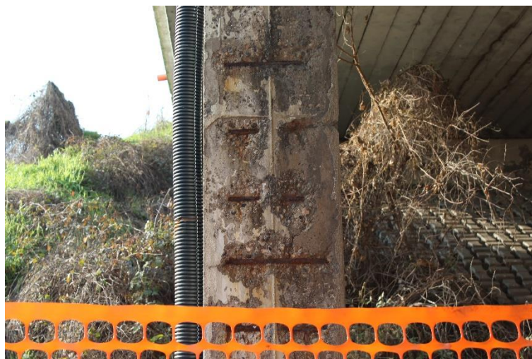
Figura 63: Manufatto BSSPEXSS45B_P001: pilastro P1 (fusto).
