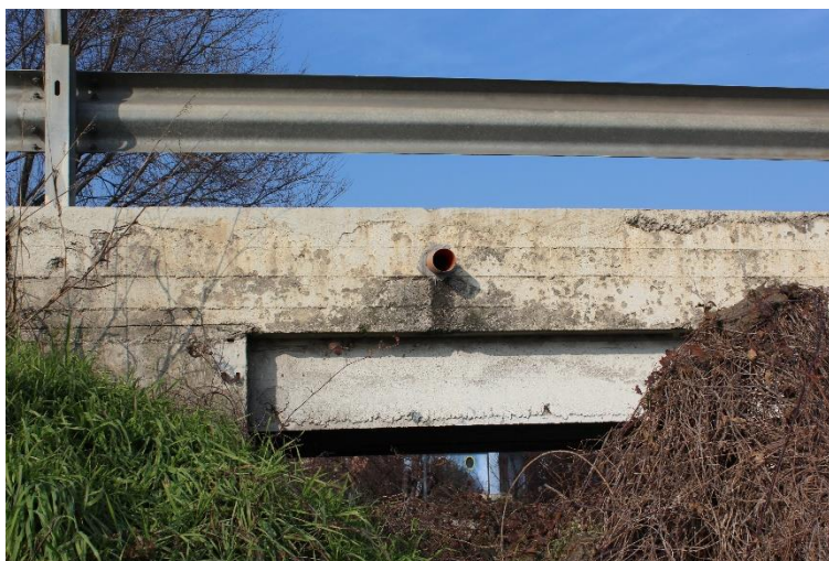
Figura 109: Manufatto BSSPEXSS45B_P001: cordolo C1 (campata sud).
