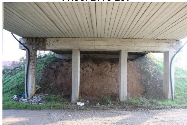
PILA SUD (LATO NORD)
