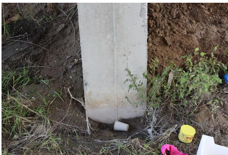
Figura 10: Manufatto BSSPEXSS45B_P004: pilastro P2 (base).
