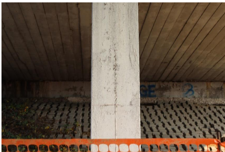
Figura 81: Manufatto BSSPEXSS45B_P001: pilastro P7 (fusto).
