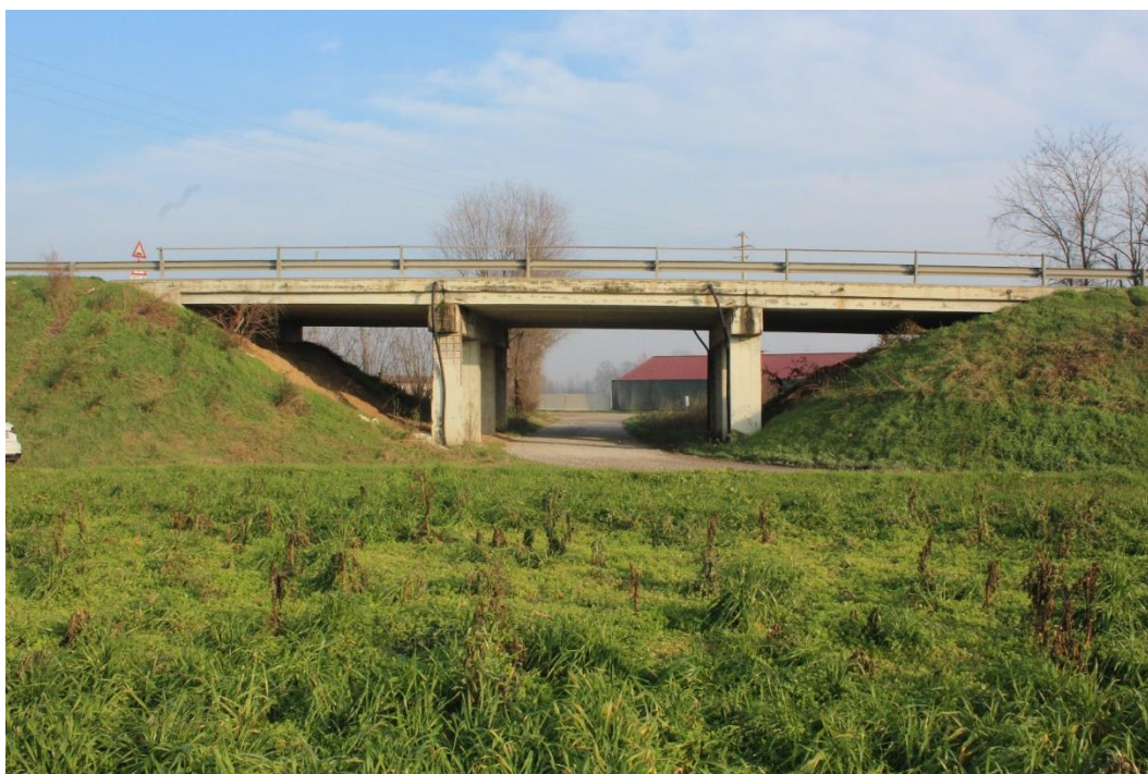
Figura 2: Manufatto BSSPEXSS45B_P004: prospetto ovest.
