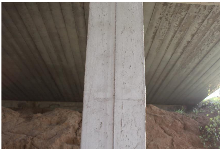
Figura 12: Manufatto BSSPEXSS45B_P004: pilastro P3 (fusto).
