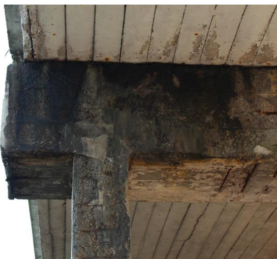
Figura 83: Manufatto BSSPEXSS45B_P001: pilastro P8 (apice).
