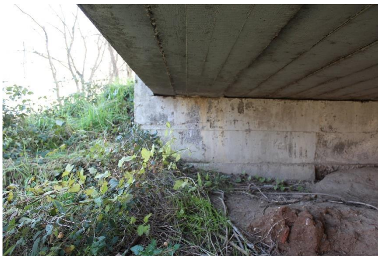
Figura 43: Manufatto BSSPEXSS45B_P004: spalla M1 (lato est).
