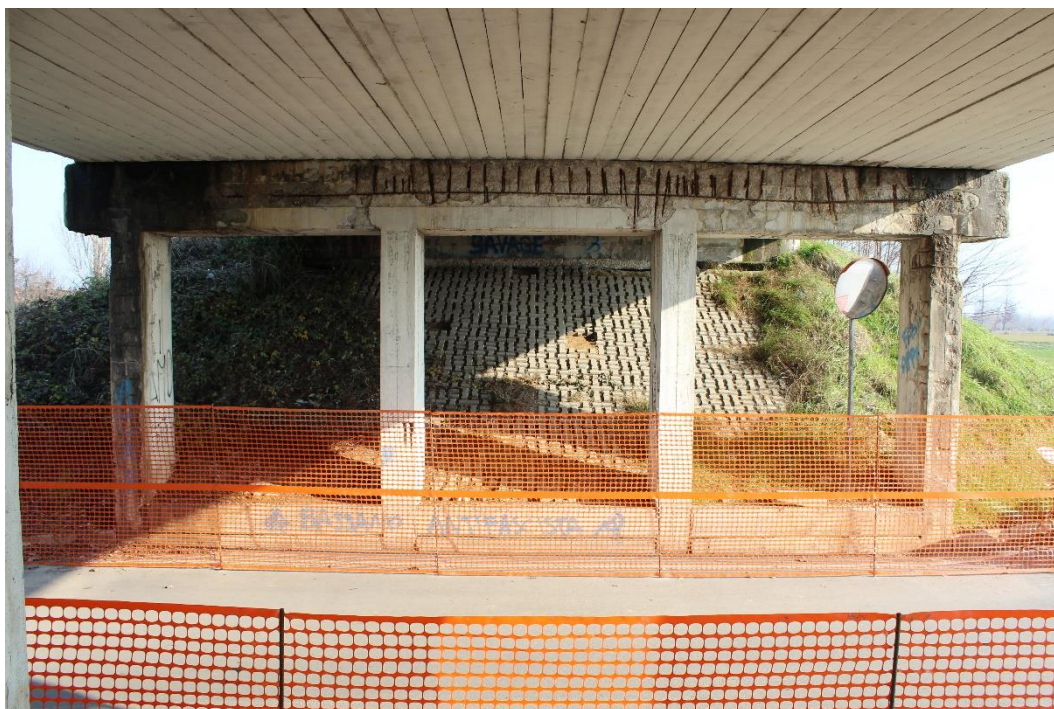
Figura 60: Manufatto BSSPEXSS45B_P001: prospetto sud (pila nord).
