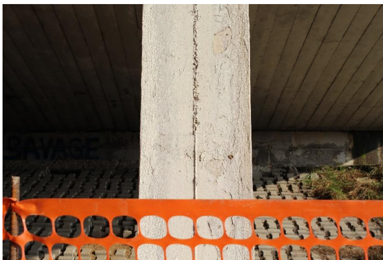
Figura 78: Manufatto BSSPEXSS45B_P001: pilastro P6 (fusto)
