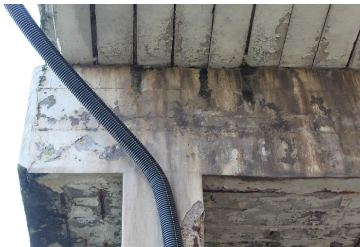
Figura 5: Manufatto BSSPEXSS45B_P004: pilastro P1 (apice).
