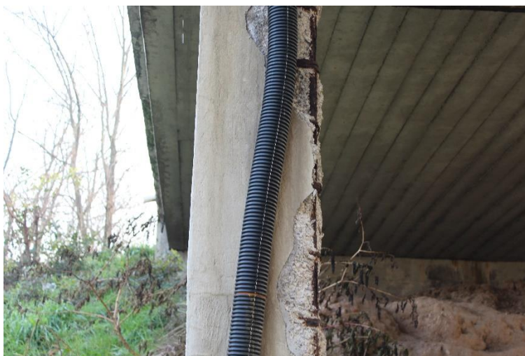
Figura 6: Manufatto BSSPEXSS45B_P004: pilastro P1 (fusto).
