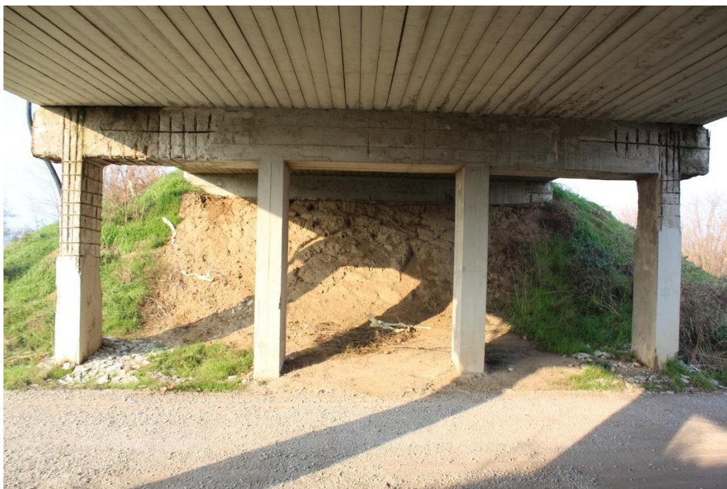
Figura 3: Manufatto BSSPEXSS45B_P004: prospetto sud (pila nord).
