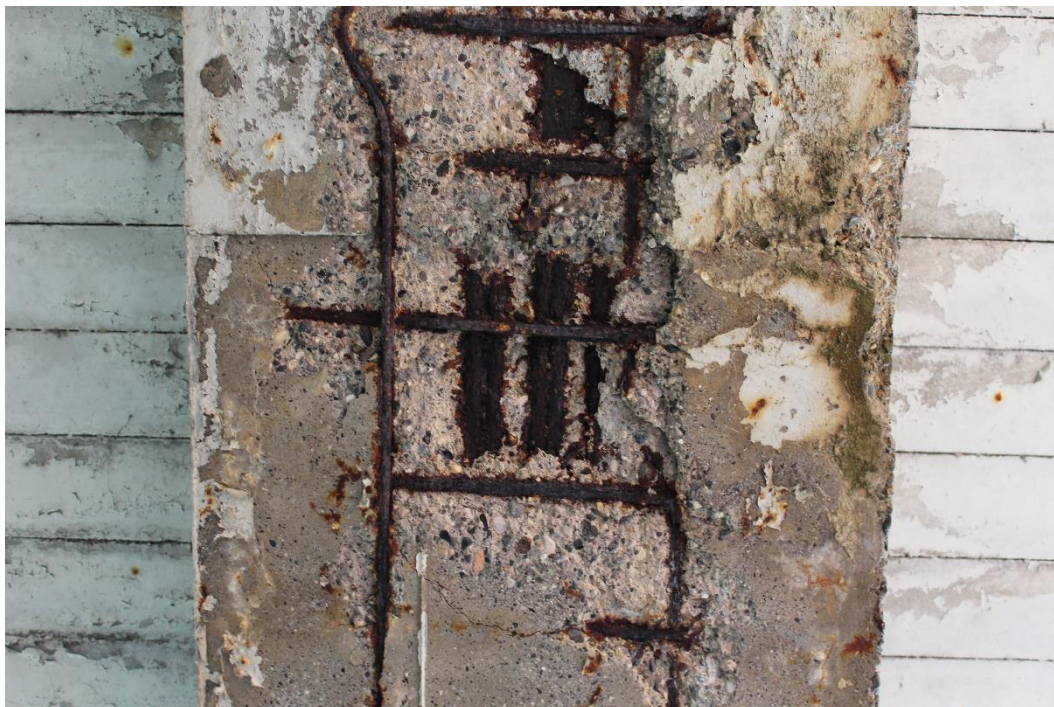
Figura 90: Manufatto BSSPEXSS45B_P001: trave T1 (campata P2-P1).
