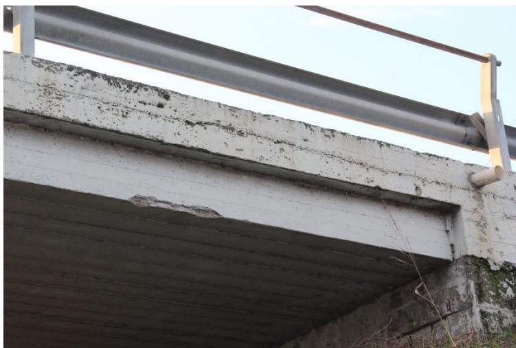
Figura 54: Manufatto BSSPEXSS45B_P004: cordolo C1 (campata nord).
