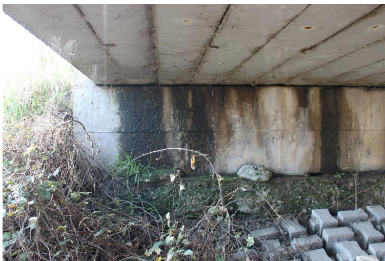
Figura 100: Manufatto BSSPEXSS45B_P001: spalla M1 (lato est).
