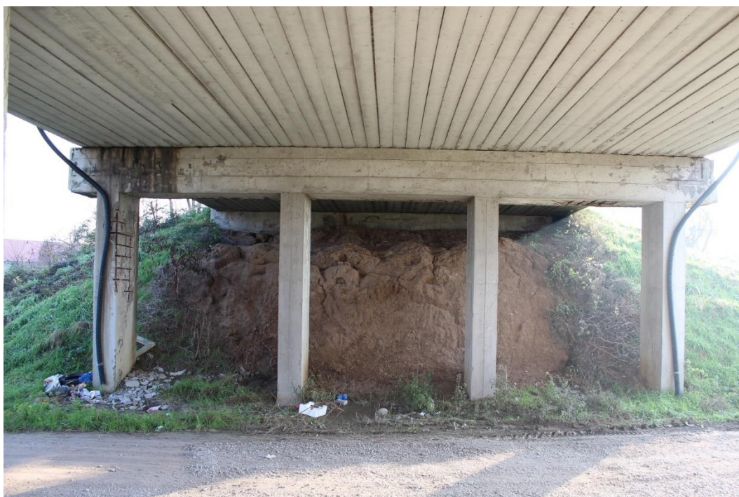
Figura 4: Manufatto BSSPEXSS45B_P004: prospetto nord (pila sud).
