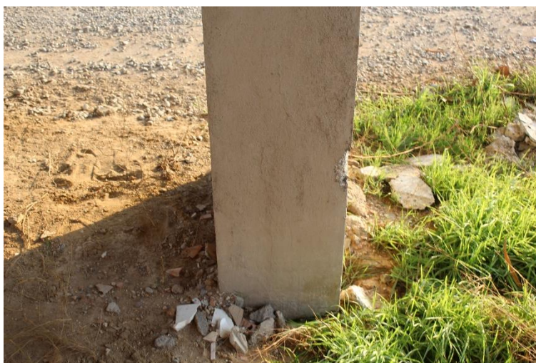
Figura 25: Manufatto BSSPEXSS45B_P004: pilastro P7 (base).
