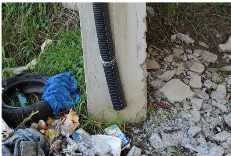
Figura 7: Manufatto BSSPEXSS45B_P004: pilastro P1 (base).
