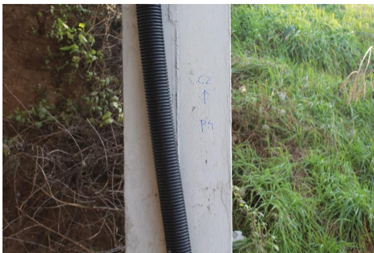
Figura 15: Manufatto BSSPEXSS45B_P004: pilastro P4 (fusto).
