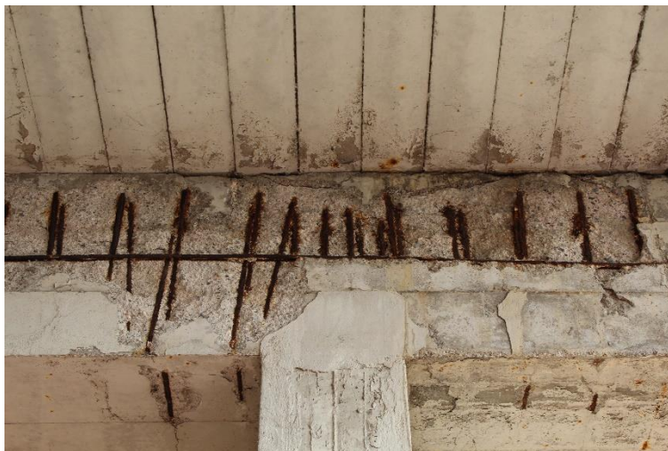
Figura 77: Manufatto BSSPEXSS45B_P001: pilastro P6 (apice).
