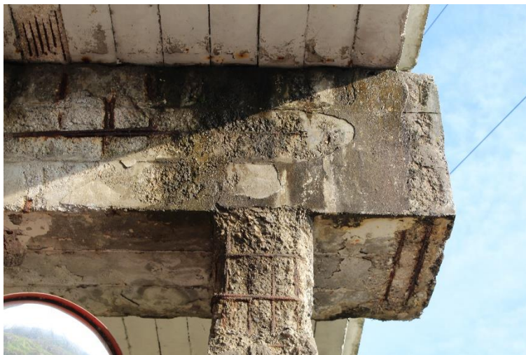
Figura 74: Manufatto BSSPEXSS45B_P001: pilastro P5 (apice).
