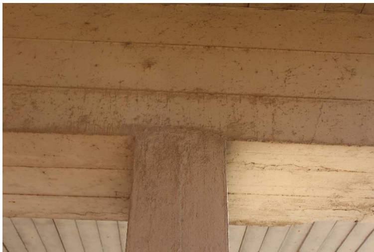
Figura 23: Manufatto BSSPEXSS45B_P004: pilastro P7 (apice).
