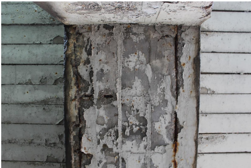
Figura 31: Manufatto BSSPEXSS45B_P004: trave T1 (campata P3-P4).
