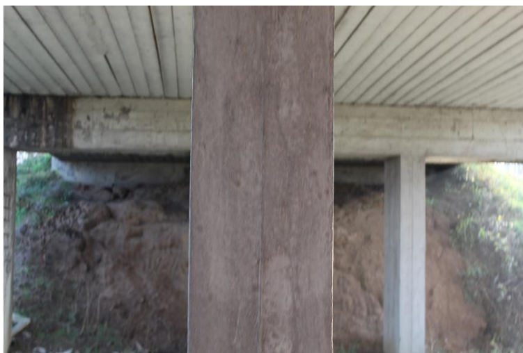
Figura 21: Manufatto BSSPEXSS45B_P004: pilastro P6 (fusto)
