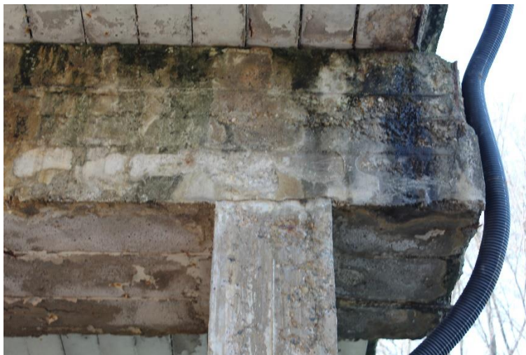
Figura 71: Manufatto BSSPEXSS45B_P001: pilastro P4 (apice).
