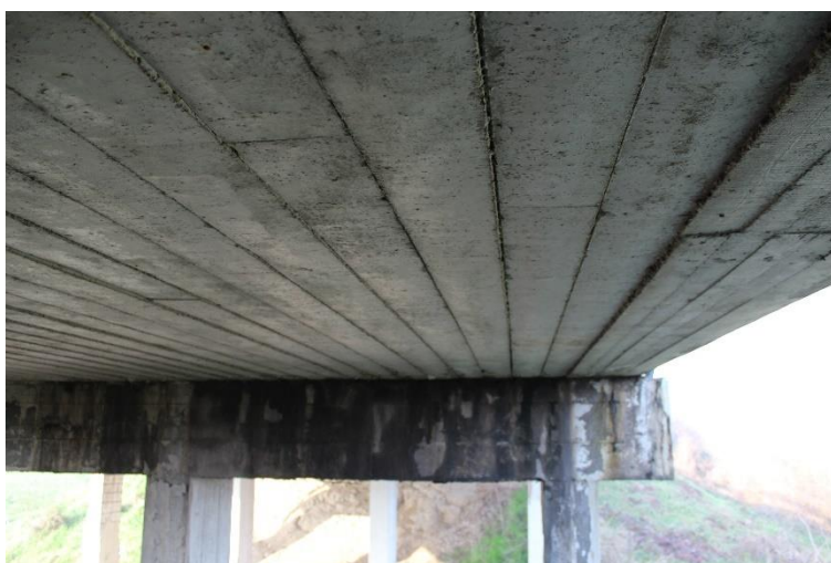
Figura 51: Manufatto BSSPEXSS45B_P004: travetti t101...t152 (lato est).
