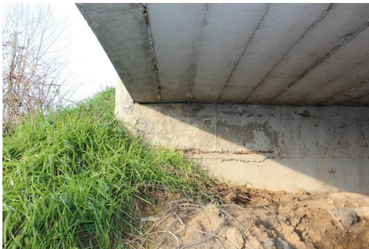
Figura 46: Manufatto BSSPEXSS45B_P004: spalla M2 (lato ovest).
