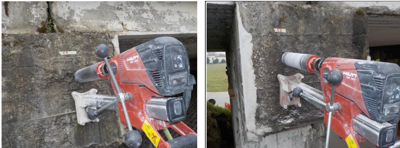
Esecuzione dei carotaggi
