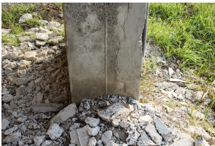
Figura 28: Manufatto BSSPEXSS45B_P004: pilastro P8 (base).
