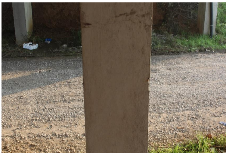
Figura 24: Manufatto BSSPEXSS45B_P004: pilastro P7 (fusto).
