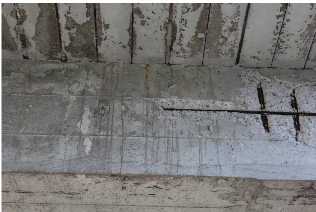
Figura 40: Manufatto BSSPEXSS45B_P004: trave T2 (campata P6-P5).
