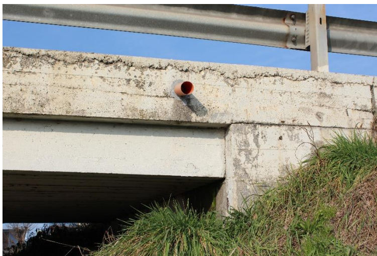
Figura 111: Manufatto BSSPEXSS45B_P001: cordolo C1 (campata nord).
