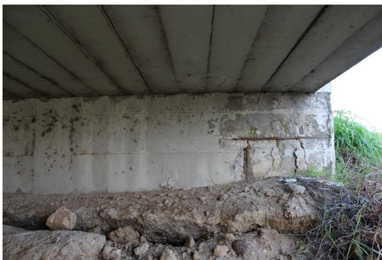
Figura 48: Manufatto BSSPEXSS45B_P004: spalla M1 (lato est).
