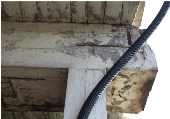
Figura 14: Manufatto BSSPEXSS45B_P004: pilastro P4 (apice).
