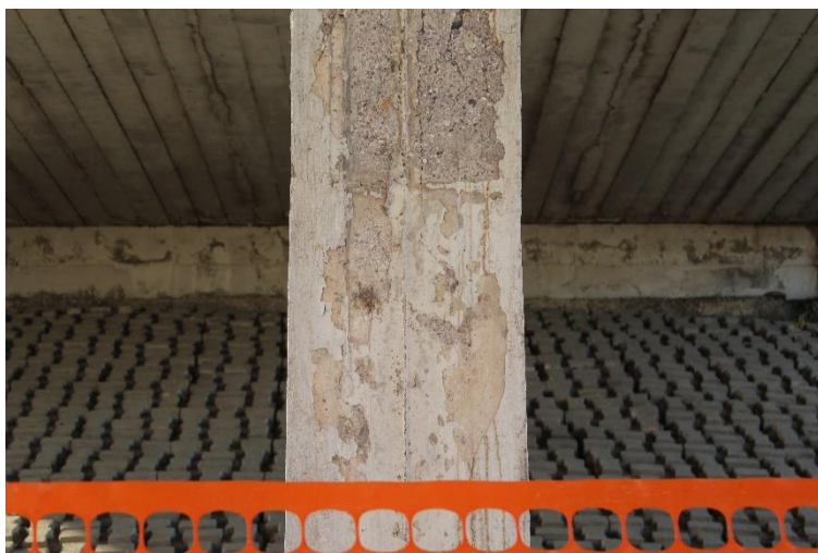
Figura 69: Manufatto BSSPEXSS45B_P001: pilastro P3 (fusto).
