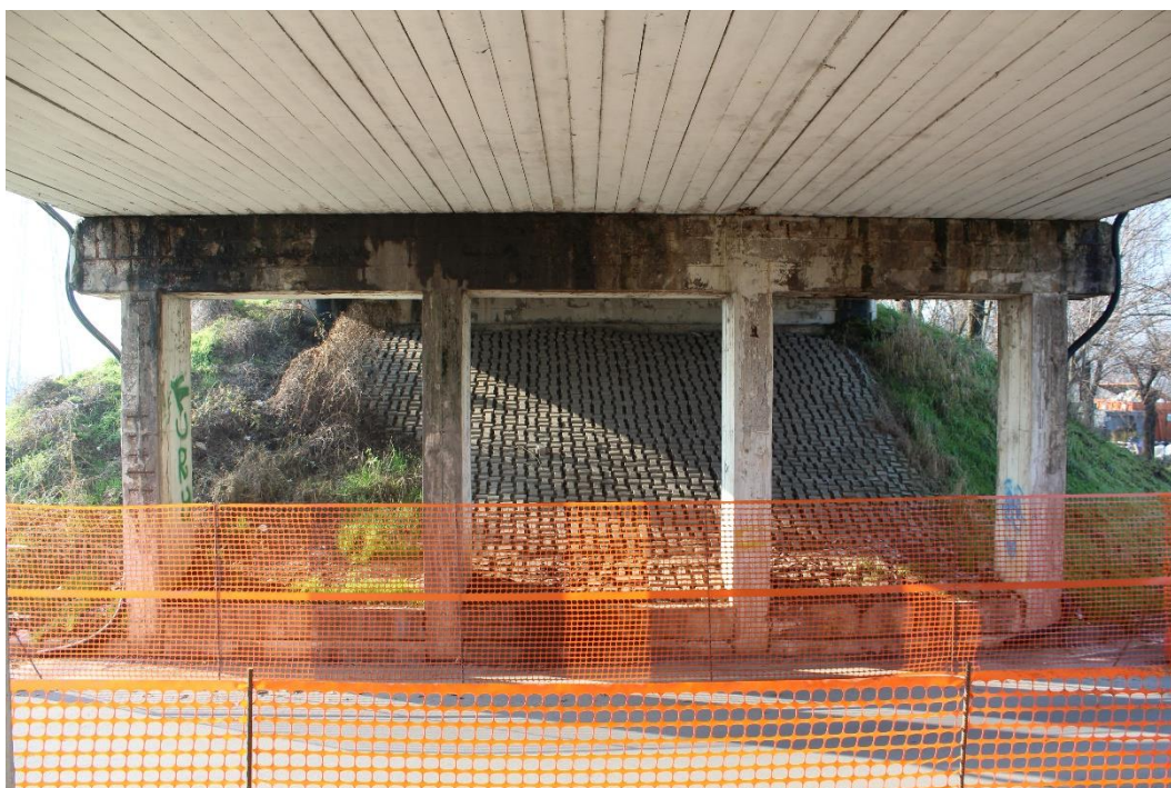
Figura 61: Manufatto BSSPEXSS45B_P001: prospetto nord (pila sud).
