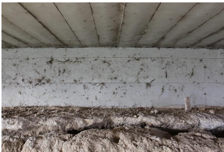
Figura 47: Manufatto BSSPEXSS45B_P004: spalla M2 (centro).
