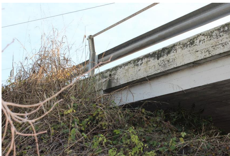
Figura 114: Manufatto BSSPEXSS45B_P001: cordolo C2 (campata nord).
