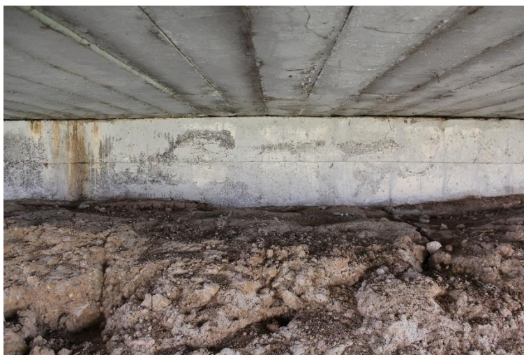
Figura 44: Manufatto BSSPEXSS45B_P004: spalla M1 (centro).
