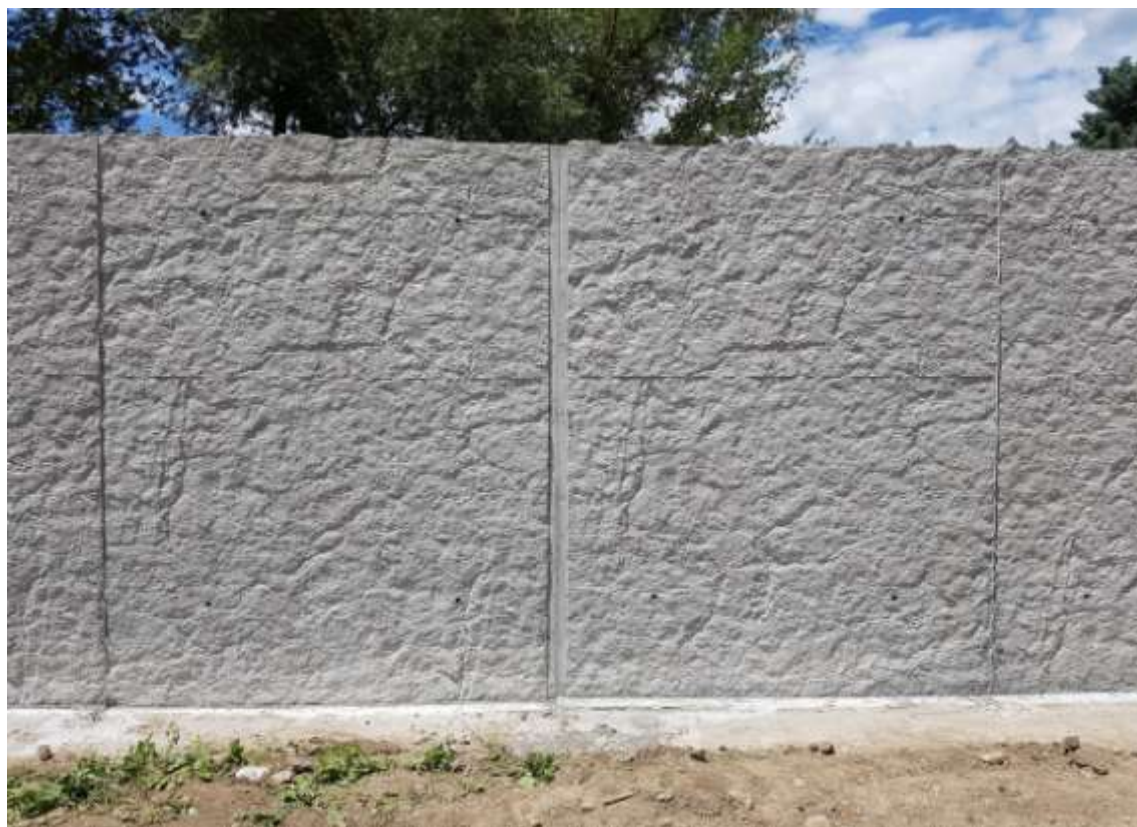
Esempio di realizzazione muro di contenimento in calcestruzzo architettonico con finitura faccia a vista effetto pietra grigia, con matrici elastiche tipo RECKLI mod. Steinwald 2/156.
