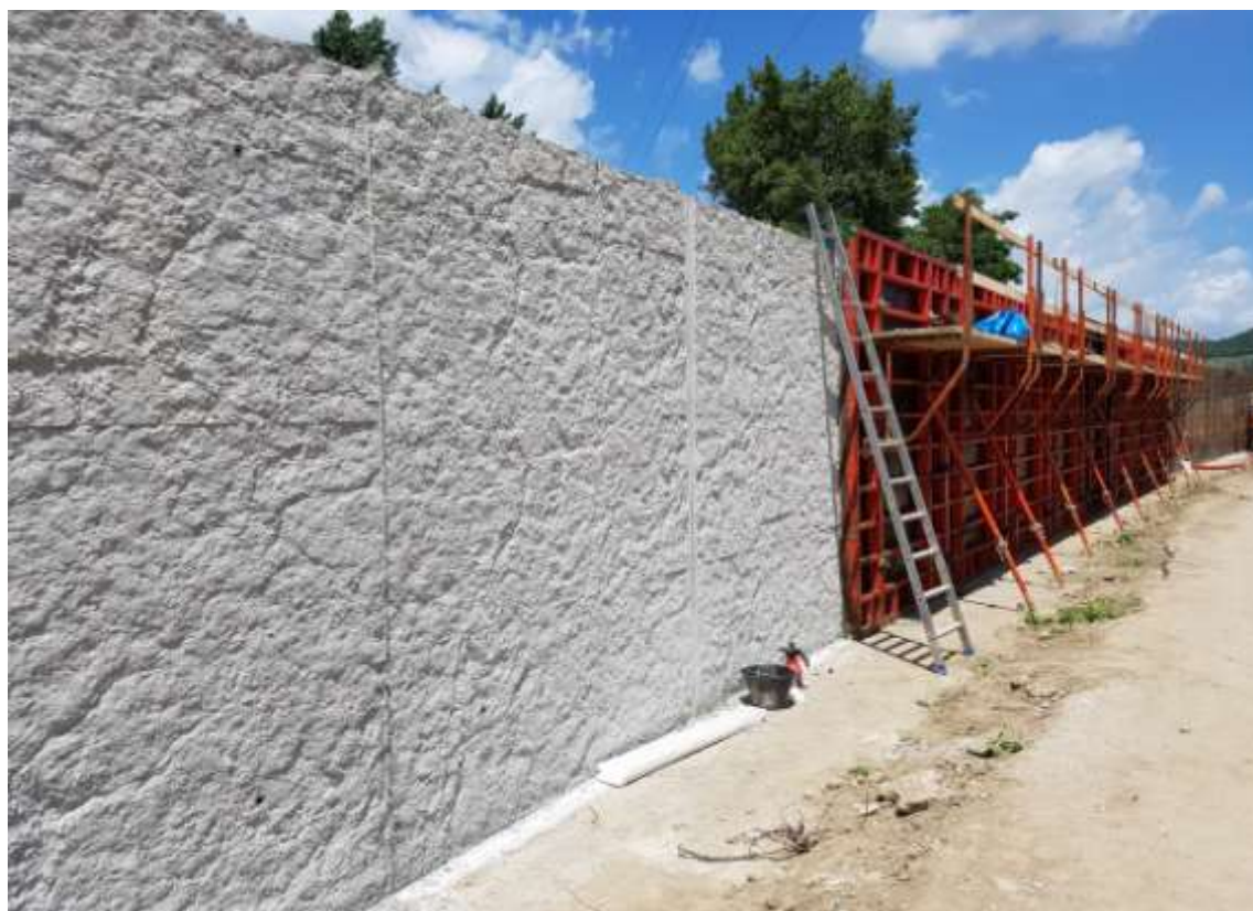
Esempio di realizzazione muro di contenimento in calcestruzzo architettonico con finitura faccia a vista effetto pietra grigia, a mezzo utilizzo di casseri metallici per rapidità di esecuzione.
