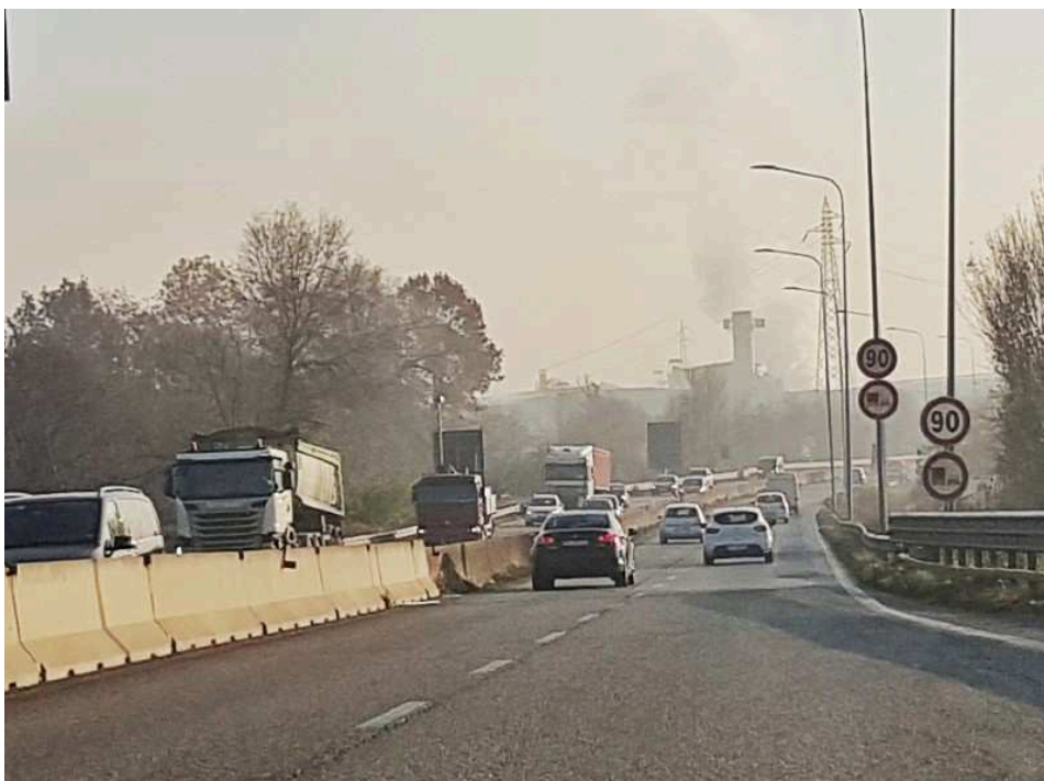
Km 9+700 – segnaletica limite di velocità in ingresso dalla rampa
