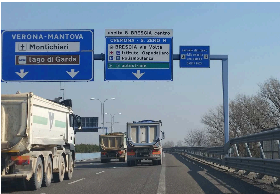
Km 8+780 – segnale di preavviso controllo elettronico della velocità con sistema Safety Tutor
