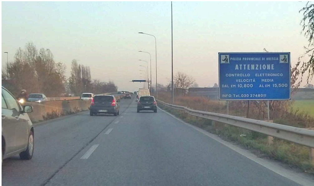
km 10+620 – secondo segnale di preavviso
