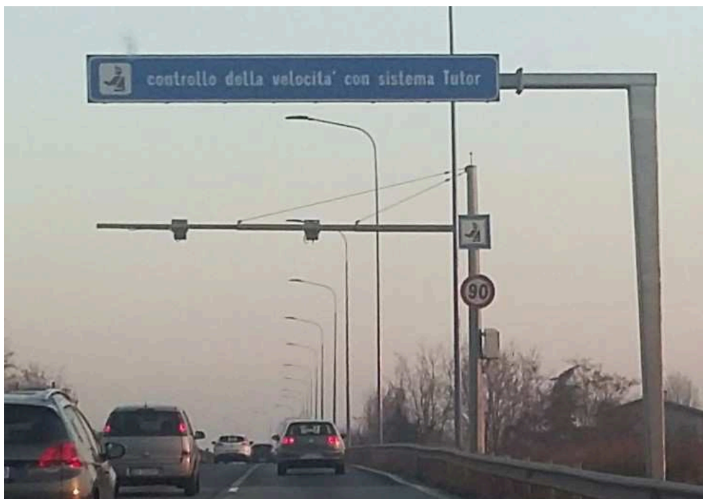
Km 10+780 – Segnale controllo velocità con sistema Tutor e km 10+800 primo blocco telecamere Tutor con segnale limite velocità massima
