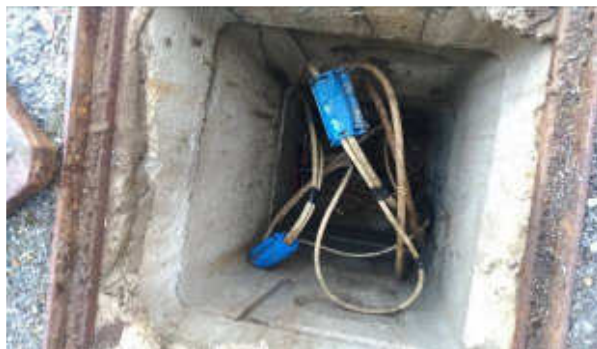
Interno pozzetto con giunzione gel
