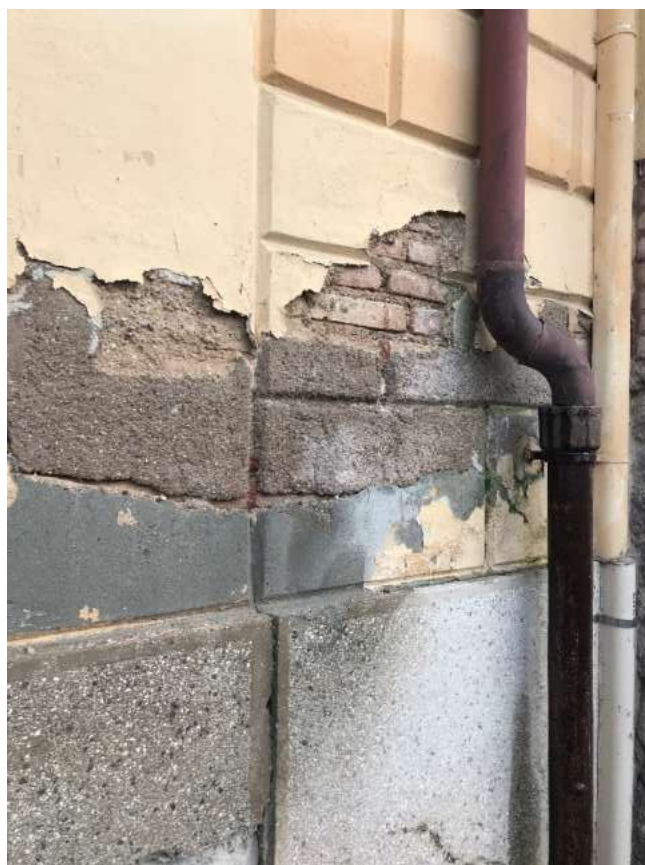
Foto n. 8 – dettaglio di scrostamento dell'intonaco in corrispondenza del pluviale
