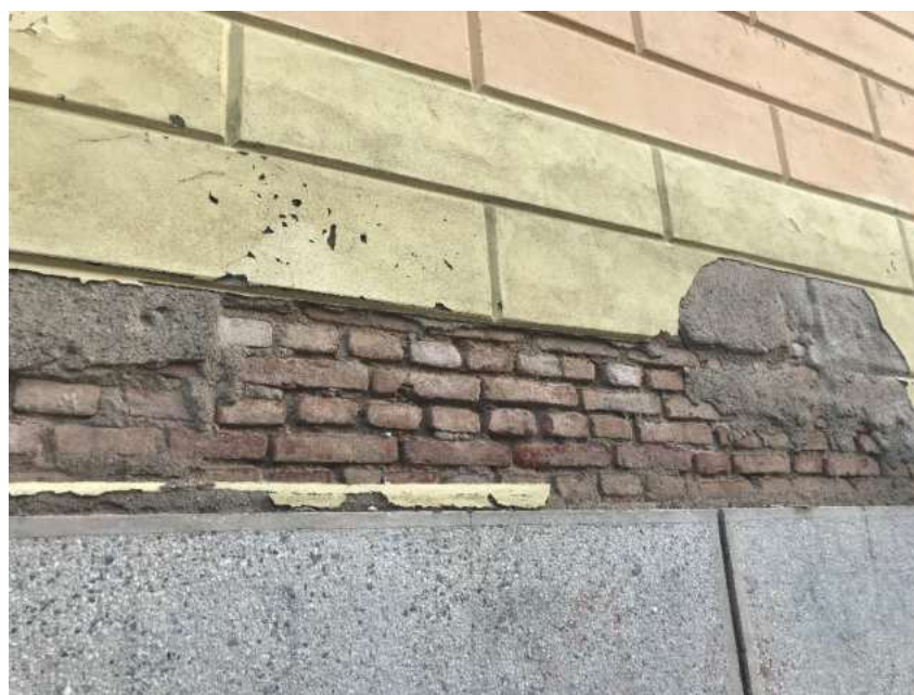
Foto n. 12– dettaglio dello scrostamento dell'intonaco su via Filzi
