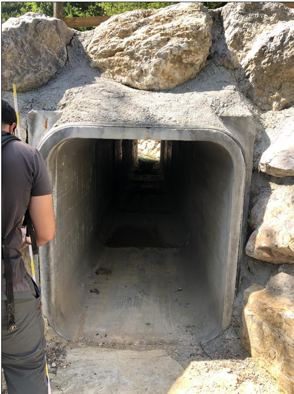
Figura 5 – Dettaglio tombotto di attraversamento in scatolare cls prefabbricato
