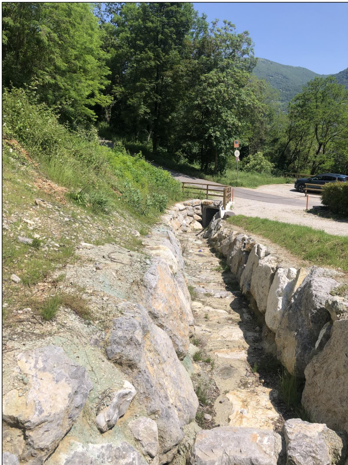
Figura 3 – Vista del tratto canalizzato in massi e malta dalla vaschetta di monte fino al tombotto di attraversamento della strada carrabile
