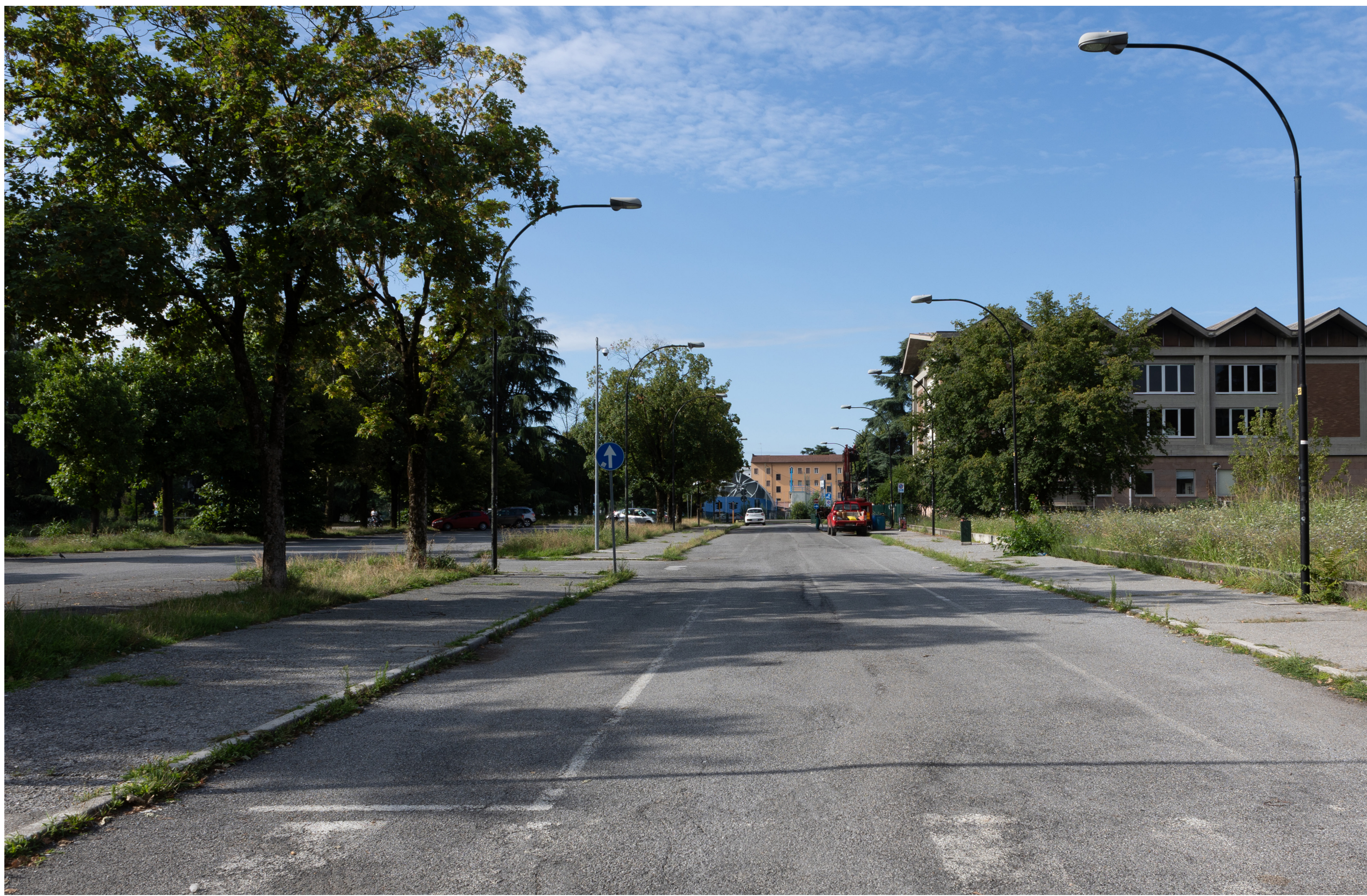
Vista A - Nord
