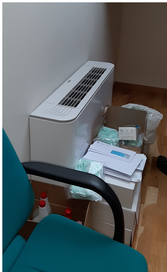
ventilconvettori sottotetto
