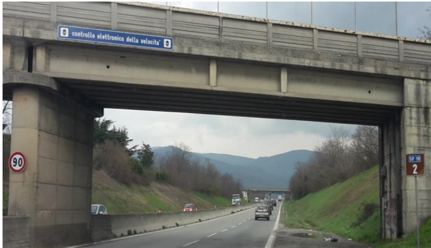
(Km 10+000 – cartello catarifrangente di preavviso del controllo)
