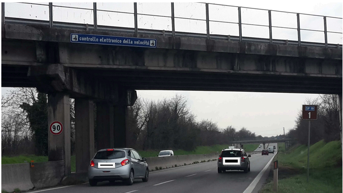
Km 9+650 -segnale di preavviso
